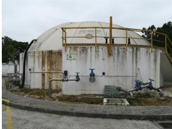
Figura 2.17- Gasómetro.
