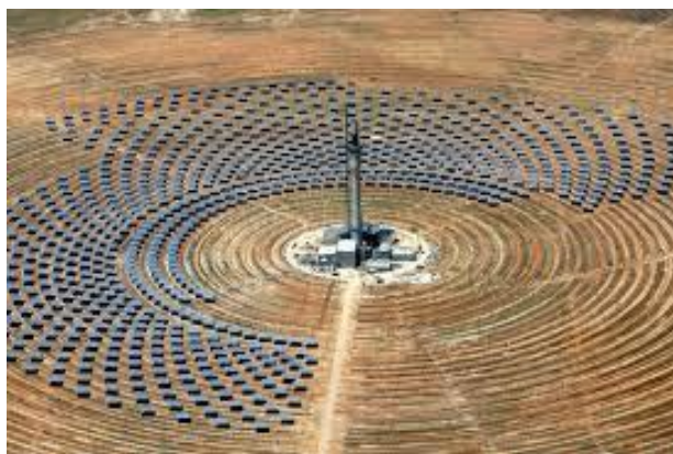
Figura 2-2: Central de Energia Solar Concentrada [2]
