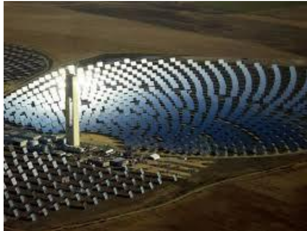
Figura 2-7: Campo solar de helióstatos [11]
