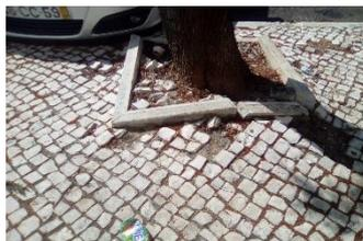
Figura 23 – Ressaltos causados pelas raízes das árvores; fonte: própria
