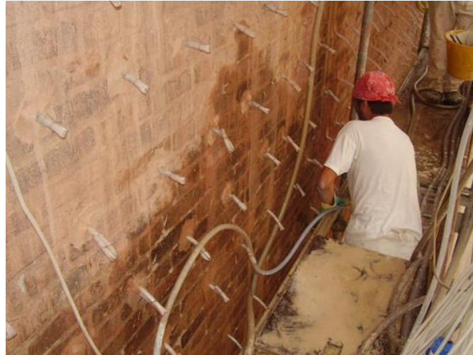
Figura 2.8 - Injeção de caldas em alvenaria [12]
