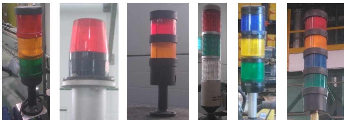
Figura 3.6 – Luzes andon existentes na fábrica
