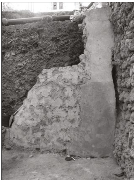
Fig. 8 – Parede oeste com porta entaipada com reboco branco.
