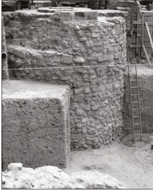
Fig. 10 – Cisterna e aterro para a construção do claustro.
