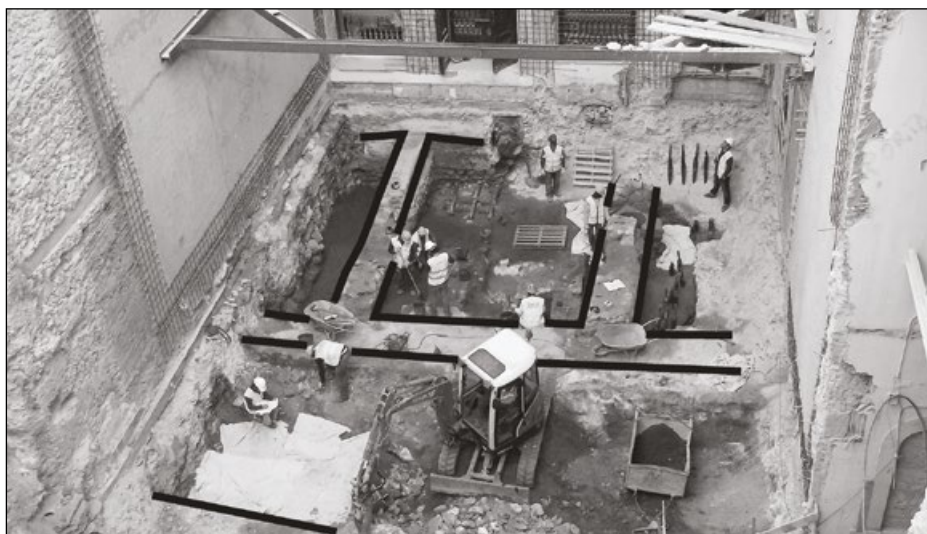
Fig. 5 – Vista dos trabalhos de escavação destacando-se os edifícios da Judiaria Nova (limites a preto) [Artur Rocha].
