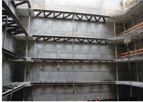
Figura 20 - Escoramento na recuperação de um edifício de habitação em Lisboa (Costa et al., 2007)
