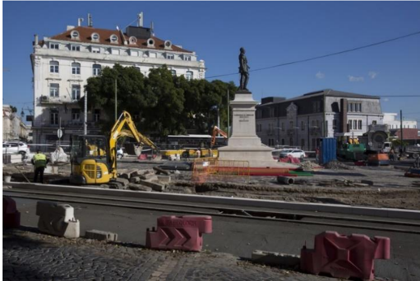
Figura 3 - Trânsito cortado devido a obras no Cais do Sodré, Lisboa (Expresso, 2016)
