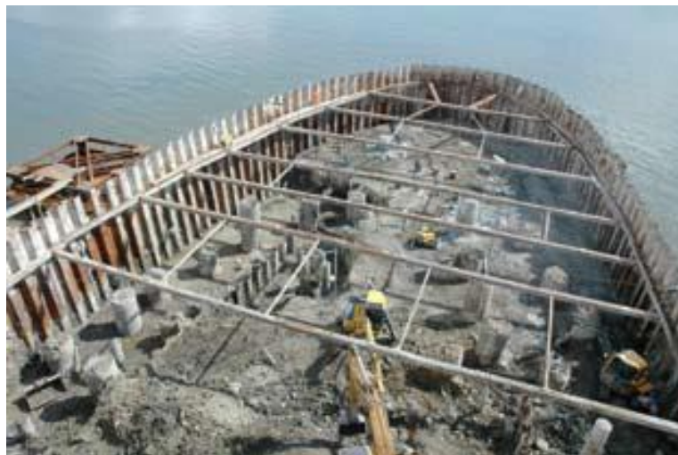
Figura 7 - Ensecadeira durante a fase de construção do Sana Torre Vasco da Gama Hotel (Pinto & Pereira, 2008)
