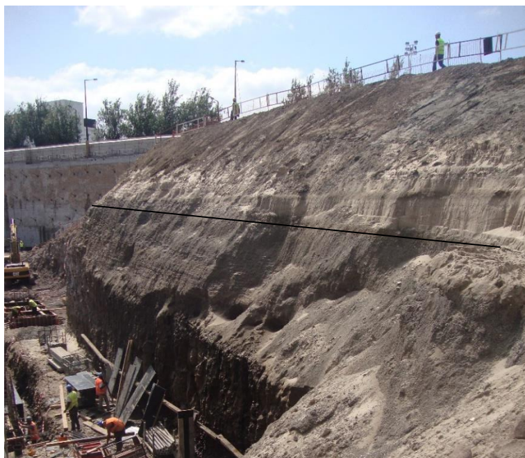
Figura 41 - Vista da transição entre o complexo aluvionar e o CVL, no talude do alinhamento 2, durante a fase de escavação.
