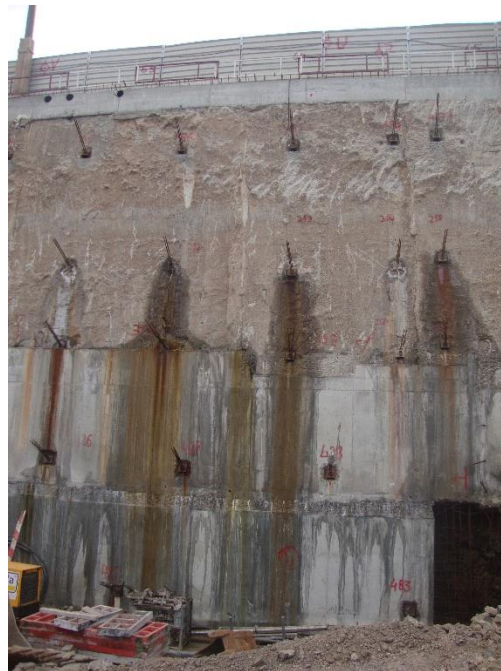
Figura 42 - Método de contenção adotado: parede moldada e parede do tipo Berlim definitiva
