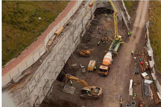
Figura 11 - Execução de parede tipo Berlim definitiva (Ancorpor Group, 2014)
