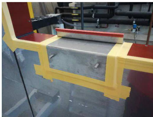
Obr. č.41: Detail kotevního plechu (vlevo) a detail vzduchotěsně přelepeného plechu (vpravo)
