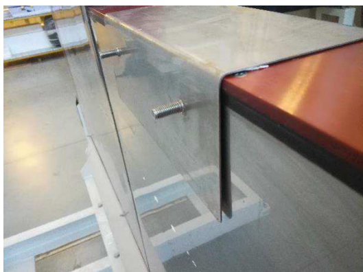
Obr. č.41: Detail kotevního plechu (vlevo) a detail vzduchotěsně přelepeného plechu (vpravo)
