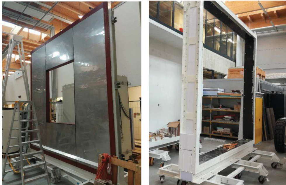
Obr. č.18: Rám s otvorem pro normové okno (vlevo) a rám pro vzorky velikosti 3 x 3 m s menší hloubkou ráku (vpravo)
