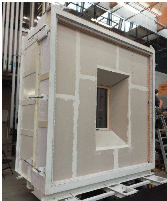
Obr. č.13: Pohled na systém stahování pomocí závitových tyčí a prodloužených matic s podložkou (zkušební vzorek - střešní okno SONG)
