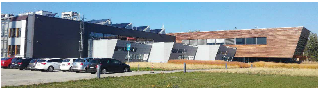
Obr. č.6: Budova Univerzitního centra energeticky efektivních budov v Buštěhradě
