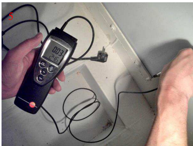
Obr. č.4: Netěsnost v plášti zkušební komory (netěsnost č. 5)
