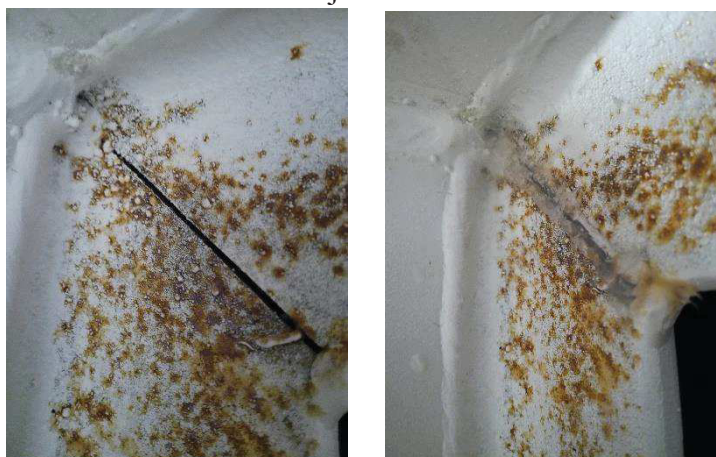
Obr. č.33: Detail netěsnosti (vlevo) a detail vyplněné a dotěsněné netěsnosti (vpravo)
