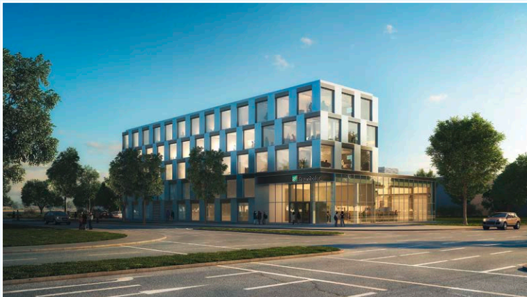
Neubau für die Fraunhofer-Projektgruppe Prozessinnovation: Der Neubau an der Universitätsstraße gegenüber dem Campus der Universität schafft modernste Computerarbeitsplätze für 60 Mitarbeiter und ermöglicht die Erweiterung der technischen Ausstattung in einer neuen Produktionshalle mit 700 m 2 .
