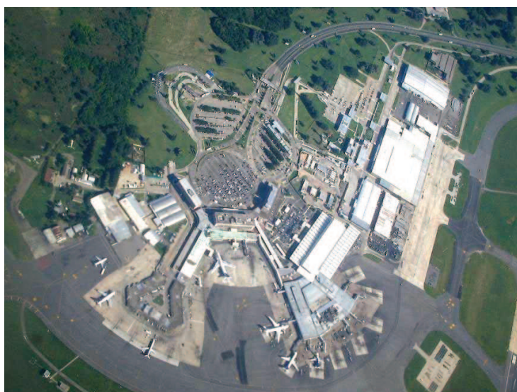
Figura 2. Falta de continuidad en la planificación: aeropuerto internacional de Ezeiza.
