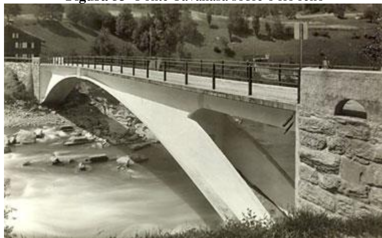
Figura 53- Ponte Tavanasa sobre o rio Reno
