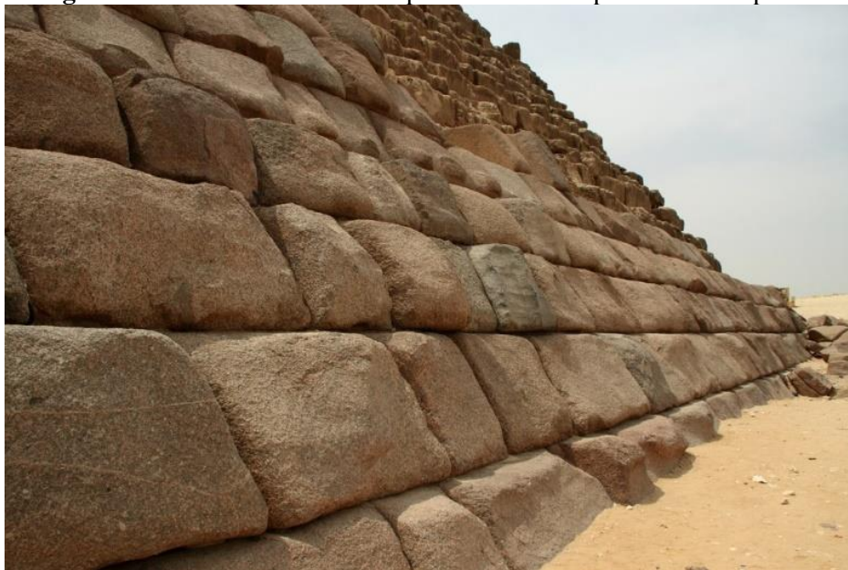
Figura 5- Detalhe da estrutura de pirâmide com empilhamento de pedras
