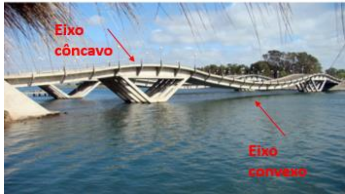
Figura 28- Ponte de La Barra Leonel Vieira- Detalhe para tabuleiro côncavo e convexo- Uruguai
