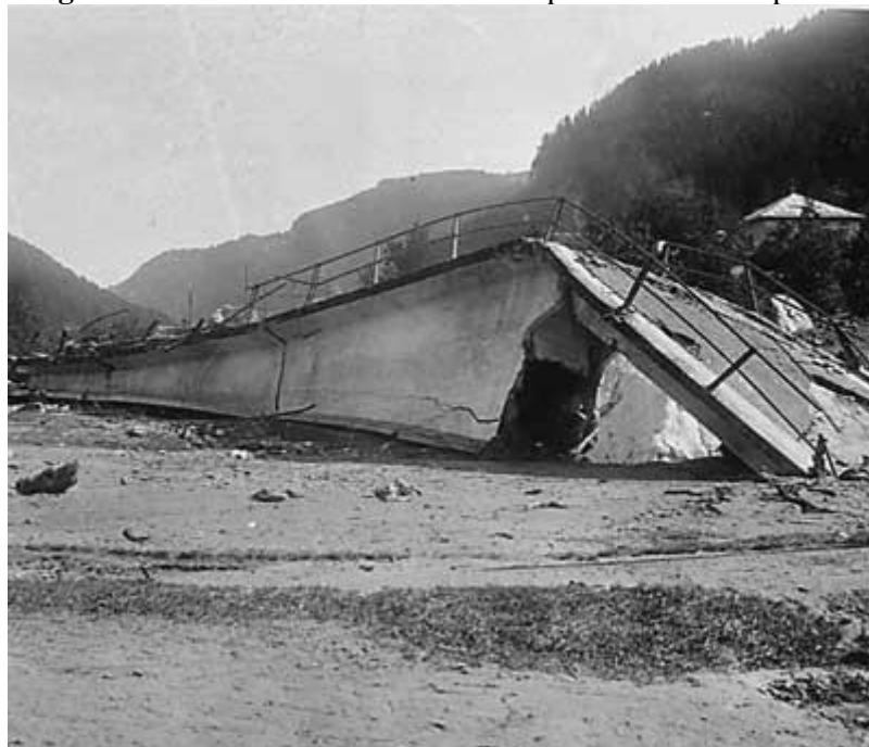
Figura 50- Ponte Tavanassa em ruínas após avalanche de pedras
