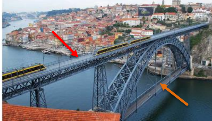
Figura 31- Ponte Dom Luis- Porto,Portugal- Possui tabuleiro superior (indicado pela seta vermelha) para transporte ferroviários e inferior para automóveis e pedestres (indicado pela seta amarela)
