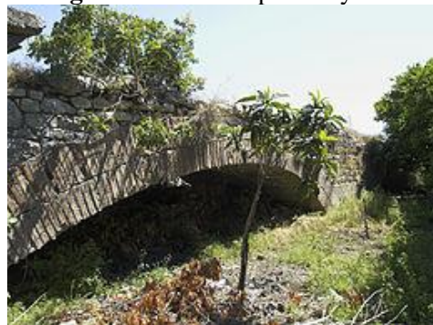
Figura 7 - Parte da ponte Lymira
