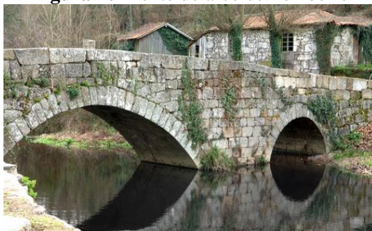
Figura 40- Ponte do arco de Pombeiro
