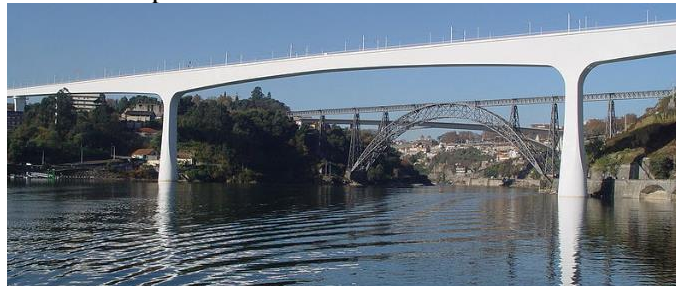
Figura 37- Ponte em pórtico- Ponte de são João sobre o rio Douro, Portugal.
