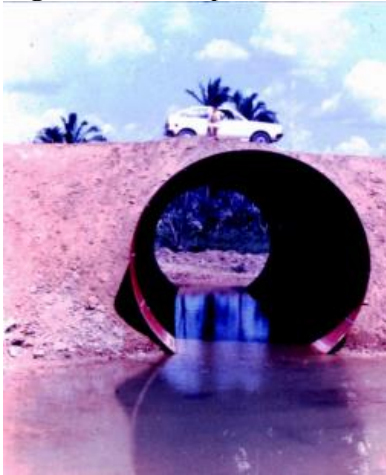
Figura 22- Exemplo de bueiro
