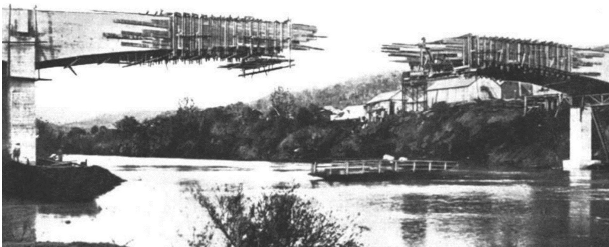
Figura 22 – Ponte do Herval Santa Catarina, em processo construtivo e acabada
