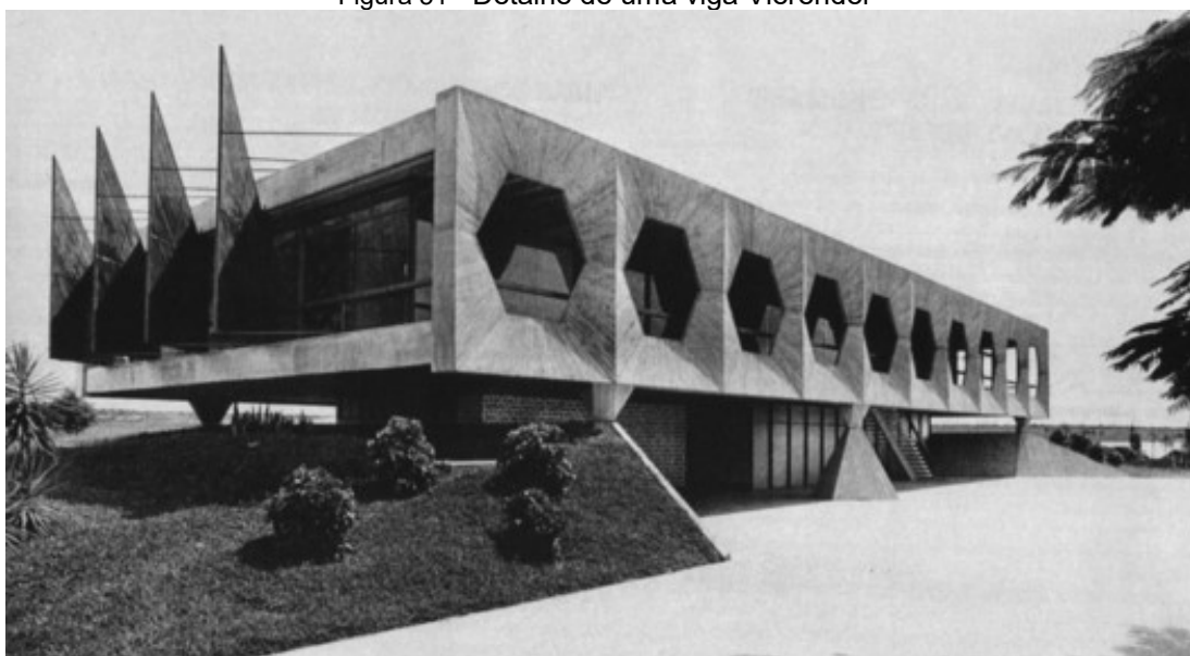
Figura 51– Detalhe de uma viga Vierendel
