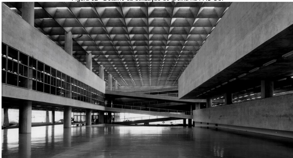
Figura 62– Detalhe da utilização de grelha na FAU USP
