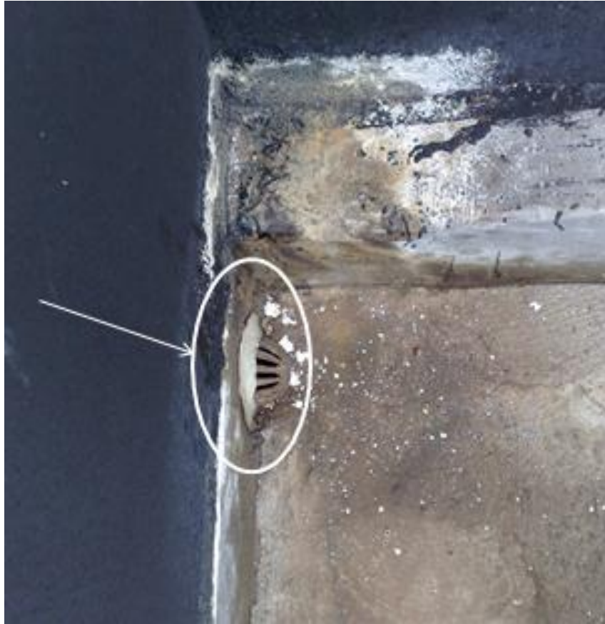
Figura 4. Detalhe da saída do cano de 100 mm na calha do telhado.
