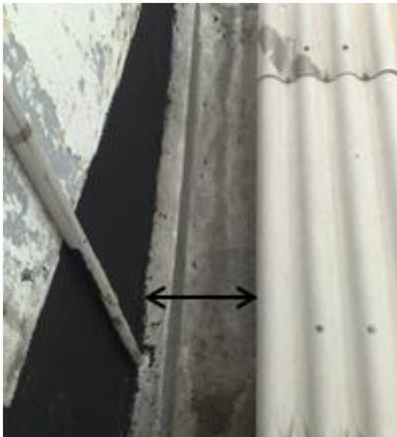
Figura 3. Detalhe das calhas impermeabilizadas do telhado.
