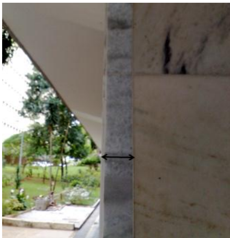
Figura 6. Acréscimo de centímetros nas colunas do andar térreo do prédio.
