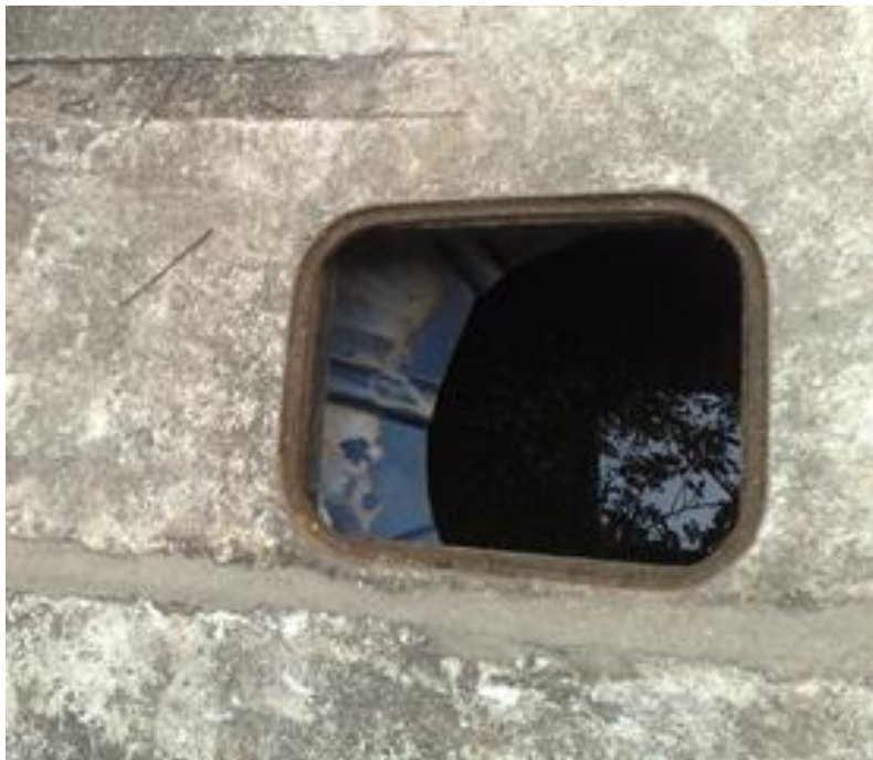
Figura 8. Detalhe da abertura da bacia de captação de água.
