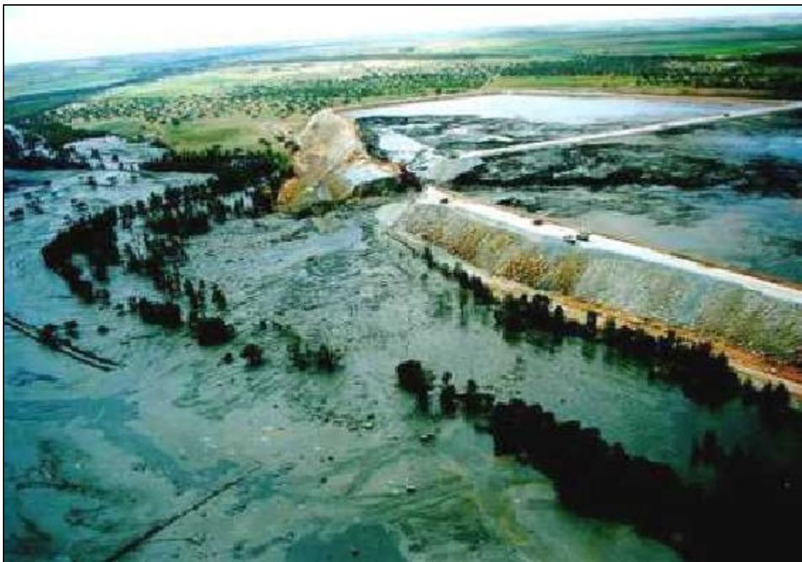
Figura 4 – Barragem de rejeitos da mina de ouro de Los Frailes, na Espanha, rompida em 1998. Fonte: Jornal Alerta Paracatu (2009)
