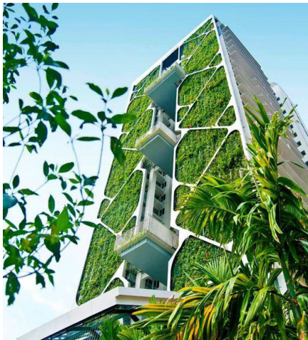
Aplicación de un sistema de jardín vertical en una fachada de edificio
