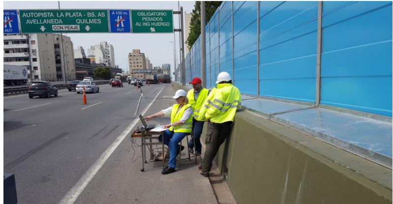
Medición de ruido de tránsito rodado en AU. 25 de Mayo
