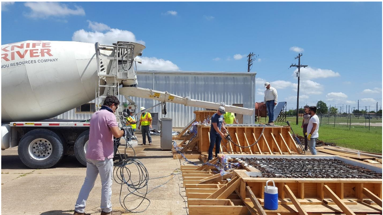
Figure 51 Specimen 2- Concrete Pour
