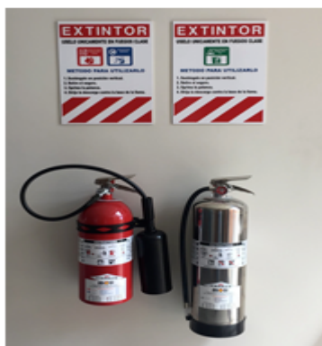
Figura v -27. Instalación de extintores portátiles
