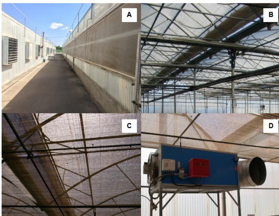
**Figura 3.8.1.** Sistema de climatización de invernaderos en la empresa Barberet & Blanc, S.A. by Dummen Orange. **(A)** Sistema de enfriamiento evaporativo. **(B)** Ventilación cenital. **(C)** Malla de sombreado. **(D)** Calefactor.
