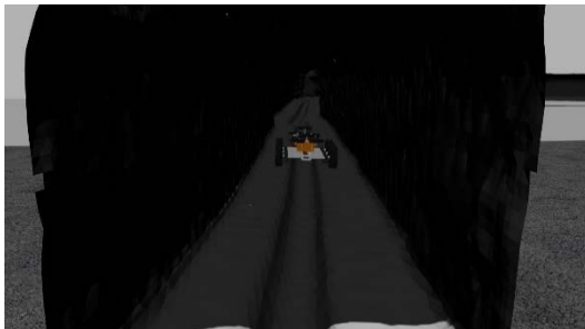
Figura 6. 42 Desplazamiento del robot SIAR al interior del alcantarillado con ligero deslizamiento
