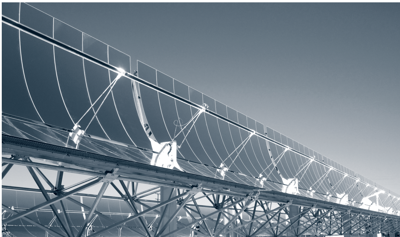
Figura 1. Colector solar cilindro-parabólico, ejemplo de invención.
