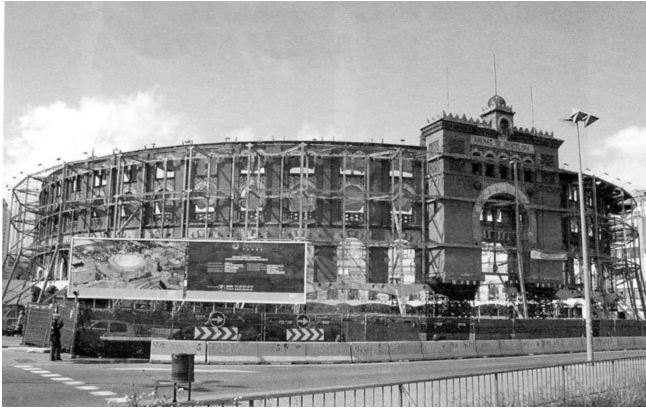
Fig. n.º 20.- El recinto de la antigua plaza de toros de Las Arenas en una imagen tomada en abril de 2006, en el curso de su transformación en un centro comercial.
