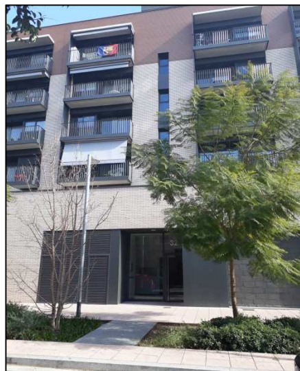
Entrada bloc habitatges
