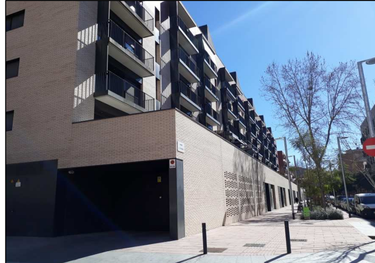
Façana oest, cantonada nord
