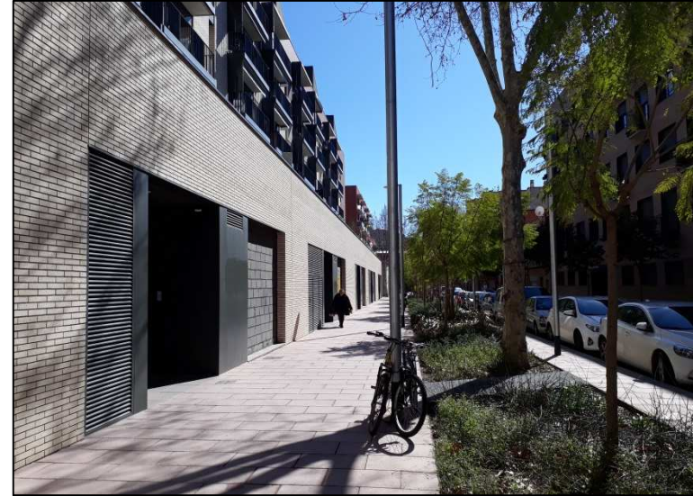
Façana oest, cantonada nord
