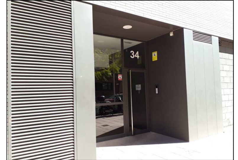
Entrada tipus bloc habitatges
