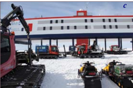
Abb. 5.1-6: a) Die Neumayer-Station III ist seit 2009 die permanent besetzte, zentrale wissenschaftliche und logistische Basis für das deutsche Polarprogramm (Foto: D. Steinhage, AWI). b) Das 2.300 t schwere Stationsgebäude wird von 16 hydraulisch steuerbaren Bipod-Zylindern getragen und in jeder Sommersaison angehoben (Foto: T. Matz, AWI). c: Neumayer-Station III, Fahrzeugpark für Traversen und wissenschaftliche Feldarbeiten (Foto: J. Asseng, AWI).
