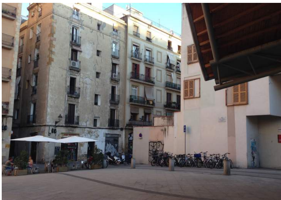
Imagen de la convivencia de edificios históricos y nuevos. Barrio de Santa Caterina. Fuente: fotografía de la autora de esta investigación.
