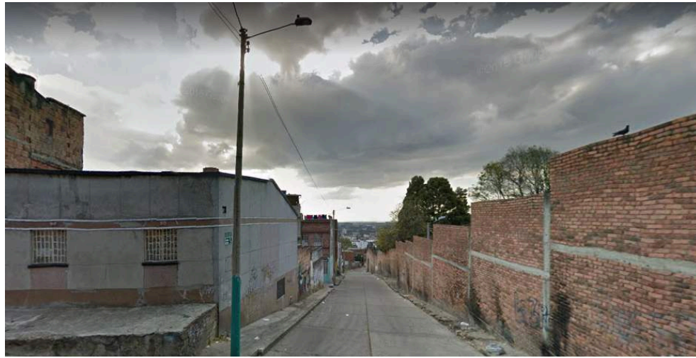
Imagen del muro del Colegio San Bartolomé. Fuente: Google Maps.
