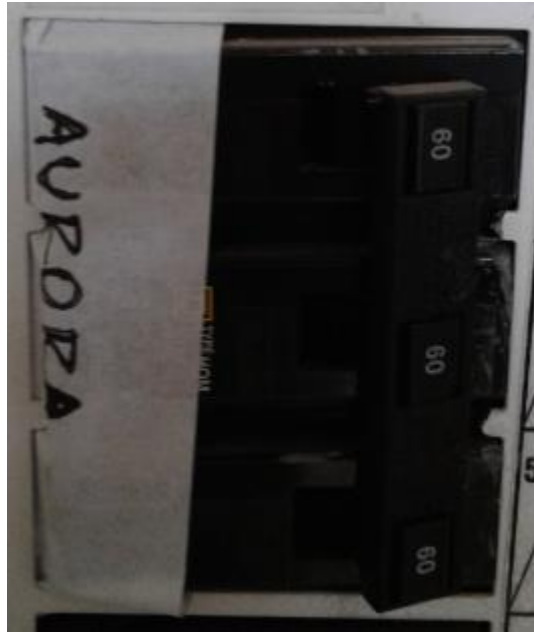
Figura 2.16. Protección de conexión a RED equipo AURORA
