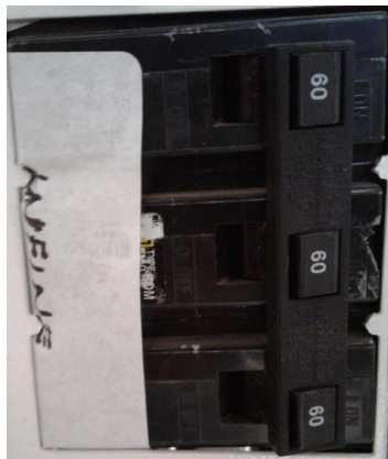
Figura 2.7. Protección de conexión a RED equipo GEINFINI solar
