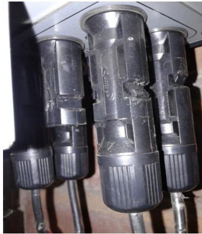
Figura 2.10. Conectores MC4 para cada entrada MPPT equipo GEINFINI SOLAR
