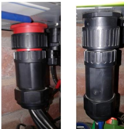
Figura 2.9. Conectores AC de carga y red equipo GEINFINI solar.
