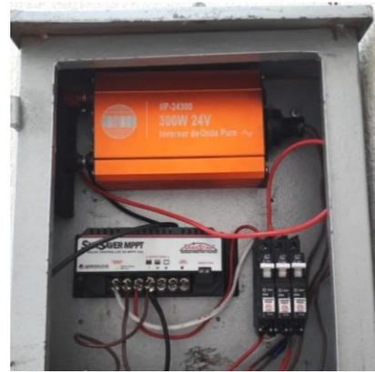
Figura. 13. Inversor de Onda Pura.
