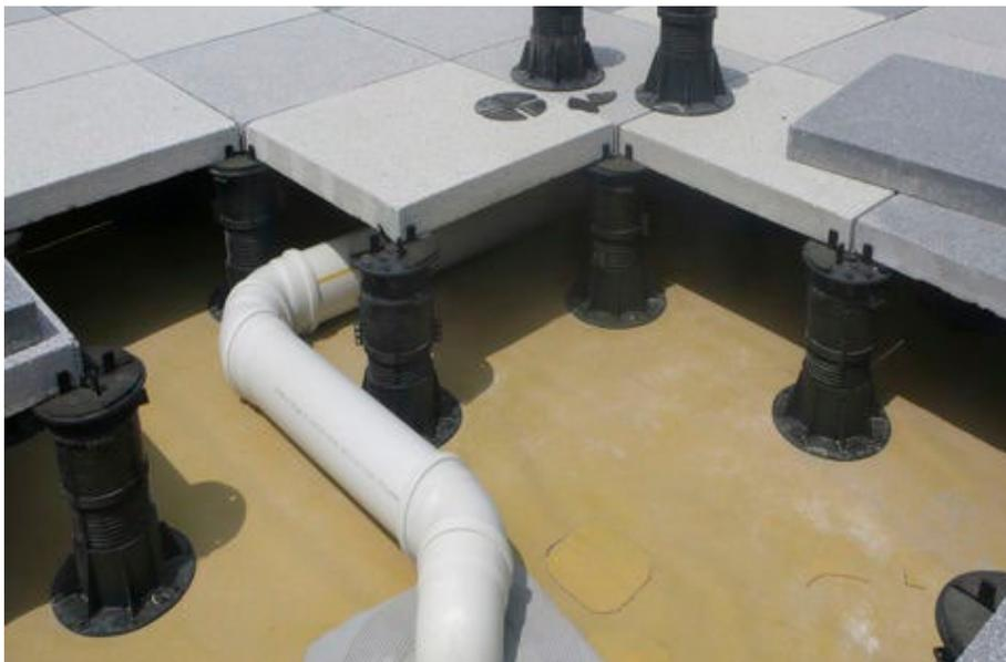
**Fig. 220**\_ Sistema de fixação indirecta para pavimento por recurso a apoio ajustável para pavimento flutuante
