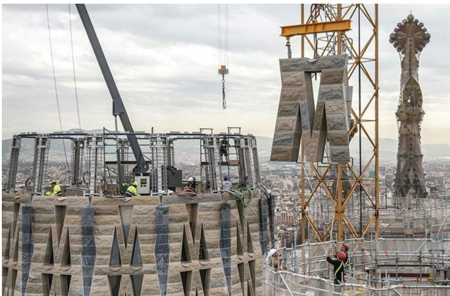
**Fig. 246**\_Montagem da Torre de S. Marcos com os painéis do compósito estrutural pétreo
