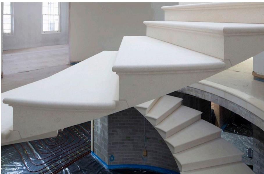
**Fig. 275\_** Detalhe do encaixe dos degraus de calcário
