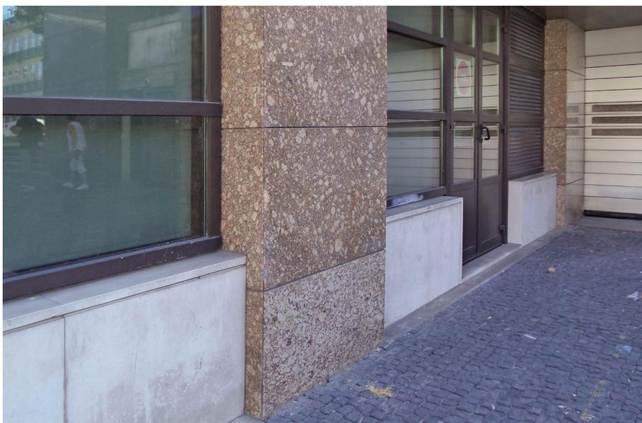
**Fig. 103**\_Seleção inadequada de placagem (placa inferior apresenta uma tonalidade distinta das restantes, Praça D. João I, Porto (2018))
