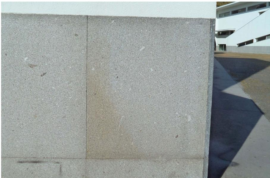
**Fig. 110**\_Descoloração de efeito moldura nas placas de granito (limite superior e inferior), assim como descoloração de ferrugem (zona inferior esquerda), Torre H, Faculdade de Arquitectura, Porto (2018)
