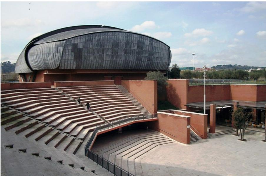
**Fig. 96**\_Auditorium Parco della Musica, vista para Sala Petrassi. Todos os muros de alvenaria exteriores apresentam manchas e eflorescências enquanto os muros protegidos pela cobertura dos pavilhão apresentam-se relativamente inalterados
