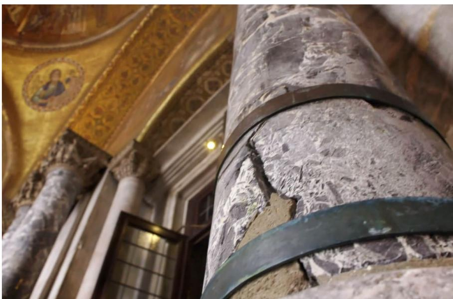
**Fig. 99**\_Pormenor da coluna fissurada no nártex da Basílica de São Marcos, Veneza, Itália
