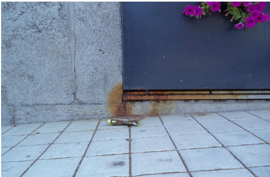
**Fig. 107**\_Descoloração provocada por manchas de ferrugem, provenientes das ferragens no canteiro, rua Dom Manuel II, Porto (2018)
