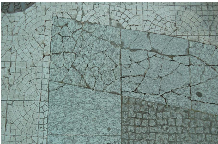
**Fig. 89**\_Fracturação do revestimento do piso de acesso a uma estação de abastecimento de combustível, incapaz de resistir às cargas de um veículo pesado, rua Júlio Dinis, Porto (2018)
