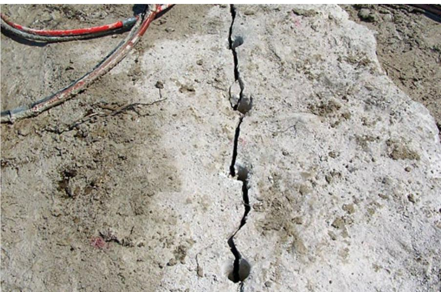
**Fig. 202** Técnica de pré-corte com recurso a uma substância não explosiva, mas expansiva que evita ondas de choque e mitiga a formação de detritos e escombros
