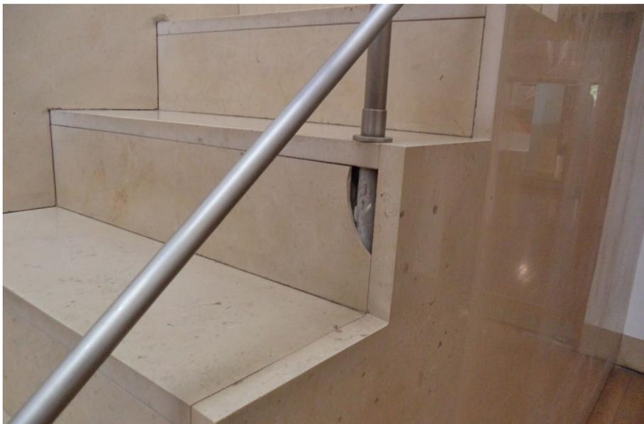
**Fig. 85** Fractura da placa de travertino do espelho do degrau. O impacto na fina placa amparada pelo varão metálico levou à fractura da peça
