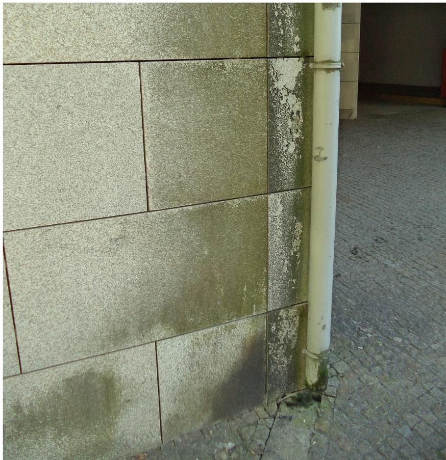
**Fig. 225** Zona da placagem de granito próxima ao tubo de queda apresenta inúmeras alterações, desde manchas, corrosão biológica e descoloração, rua interior da Faculdade de Letras, Porto (2018). A má execução do encontro entre o sistema de fixação e o sistema de drenagem de águas pluviais, a caixa do tubo de queda que marca o início das alterações, promove o desenvolvimento de anomalias. A gestão das águas é da mais alta importância para a conservação da construção
