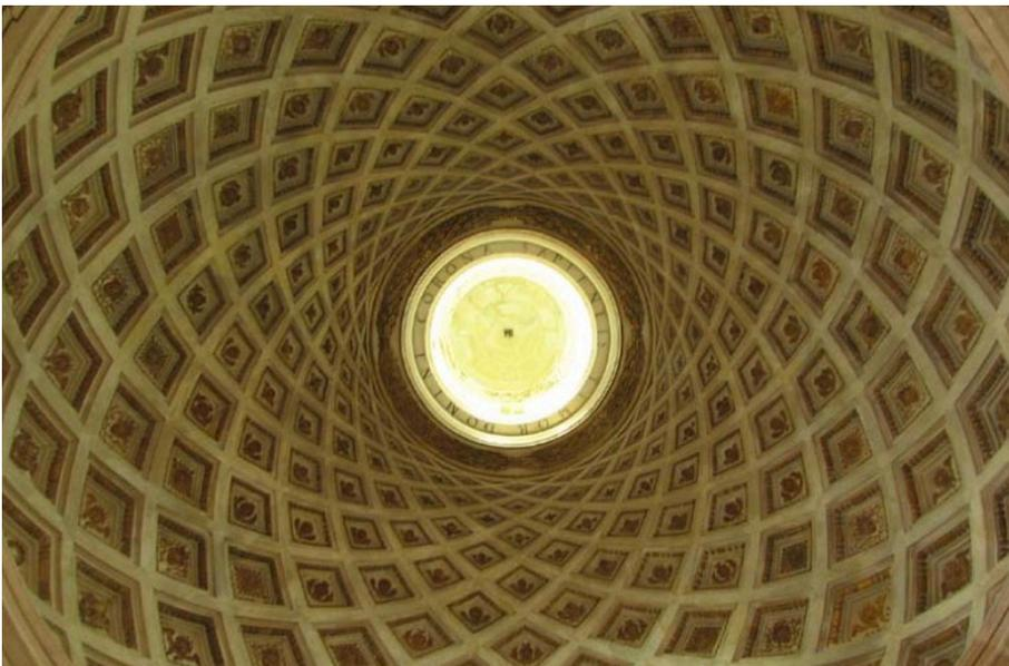
Fig. 157\_ Cúpula da capela do Château d’Anet, Philibert de l’Orme, séc. XVI. Um trabalho estereotómico perspético pois as nervuras diminuem o espaçamento entre elas enquanto ascendem na cúpula, iludindo uma estrutura mais alta do que realmente é
