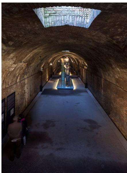
Fig. 134\_(esq.) Túnel de sistema de esgotos romano, Cologne, Alemanha, séc. I. Abóbada (em alvenaria de pedra) constitui um dos elementos principais da revolução construtiva romana, tal como as suas infraestruturas
