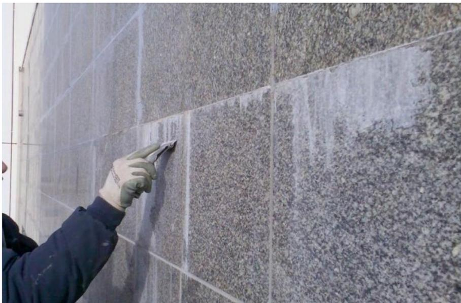
**Fig. 68**\_Eflorescência em placagem de granito
