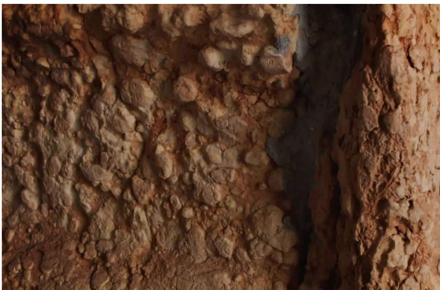
**Fig. 100**\_Pormenor da textura da base de mármore rosa da coluna, dissolvido pelos ciclos de cristalização do sal e da acqua alta, nártex da Basílica de São Marcos, Veneza, Itália
