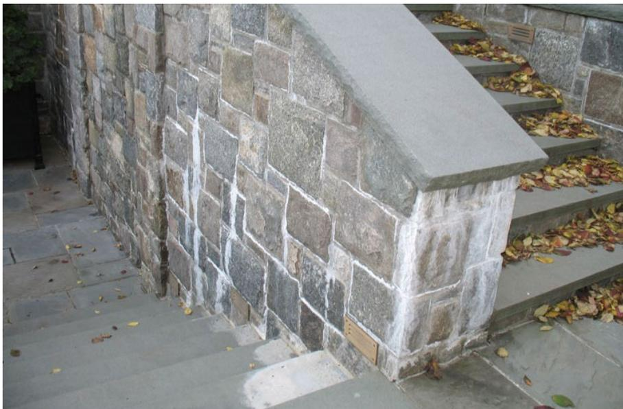
**Fig. 92**\_Eflorescências consequentes da argamassa da alvenaria e da capa do guarda-corpo da escada, assim como manchas nos cobertores próximos
