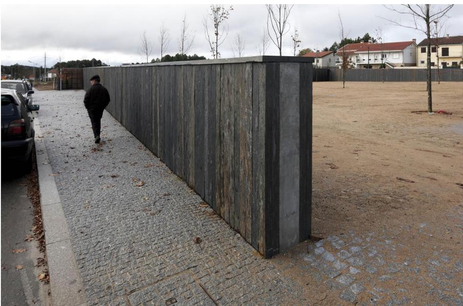
Fig. 267\_Perfil construtivo do muro perimetral que marca a entrada. Betão revestido por esteios de xisto.
