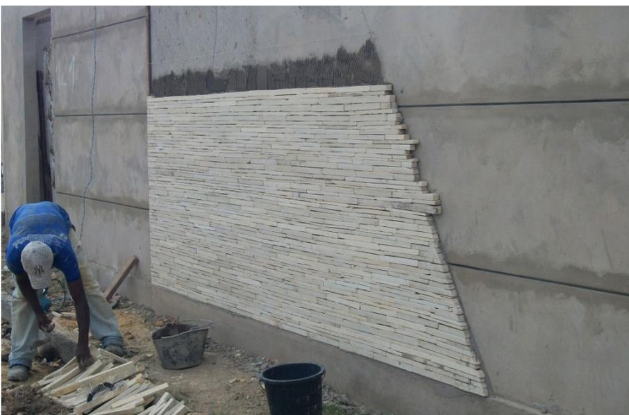
**Fig. 216**\_Fixação directa por colagem por argamassa
