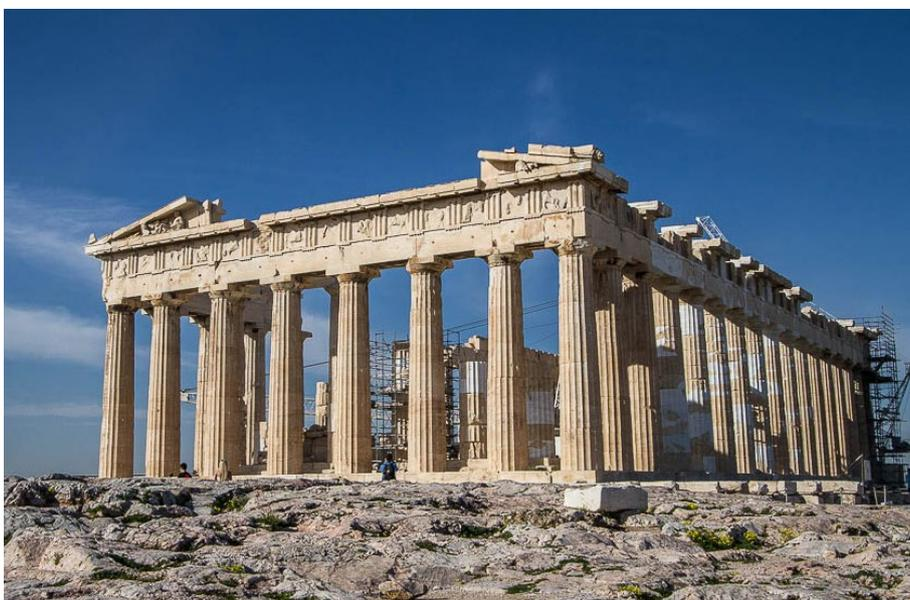
**Fig. 131**\_Pártenon, pórtico nascente, Acrópole de Atenas, Grécia. É possível ler a entasis na mudança de espessura da coluna consoante a altura. A base é relativamente mais grossa que o topo
