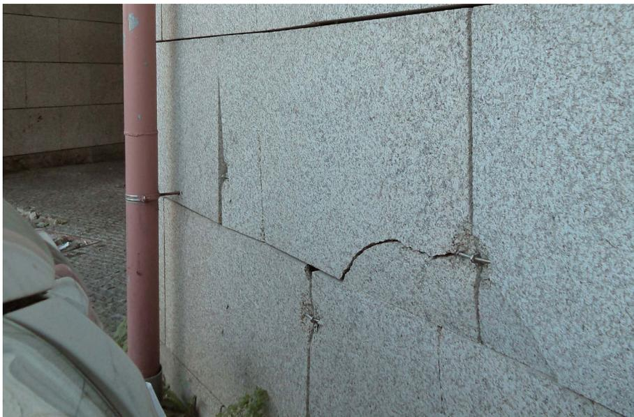
**Fig. 88**\_Placagem fracturada pelo impacto automóvel (revestimento à frente de um local usado como estacionamento), travessa da Pena, Faculdade de Letras, Porto (2018)
