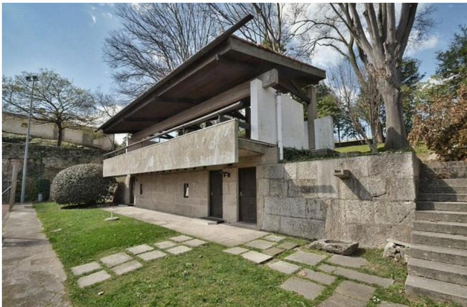
**Fig. 190\_** Pavilhão de Ténis, Fernando Távora, 1958. O muro e pilares de granitos, a guarda e a viga em betão, as asnas em madeira e as paredes rebocadas formam um simples volume rico de detalhe e identidade
