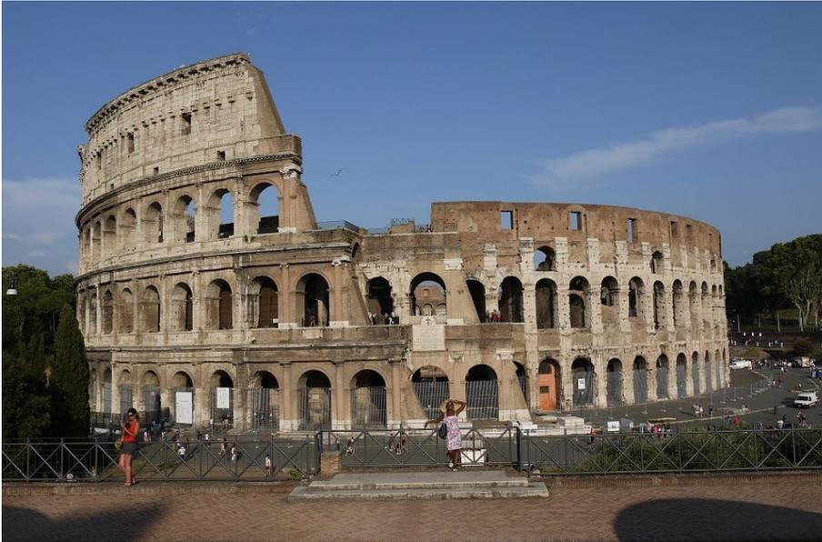
**Fig. 139**\_ Coliseu, Anfiteatro Flaviano. Um sistema de arcos estrutura a fachada circundante, reflexo do sistema de abóbadas internas que erguem as bancadas
