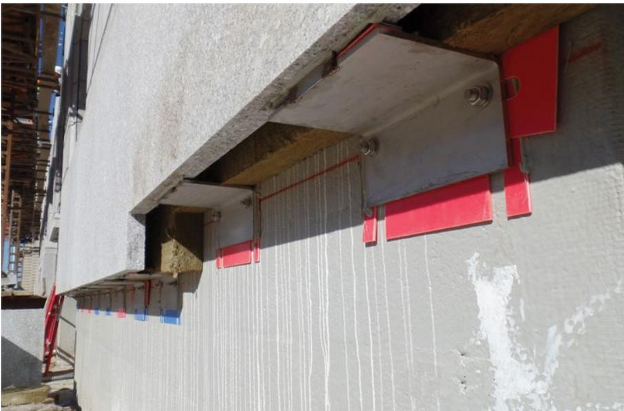
**Fig. 215**\_Fixação indireta por ancoragem de perfil dentado
