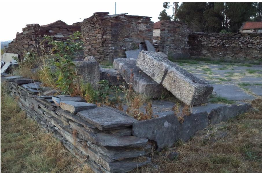
**Fig. 2**\_Ruína de casa em pedra xistenta com pátio em ardósia e peças de granito, provavelmente, guarnição de vãos
