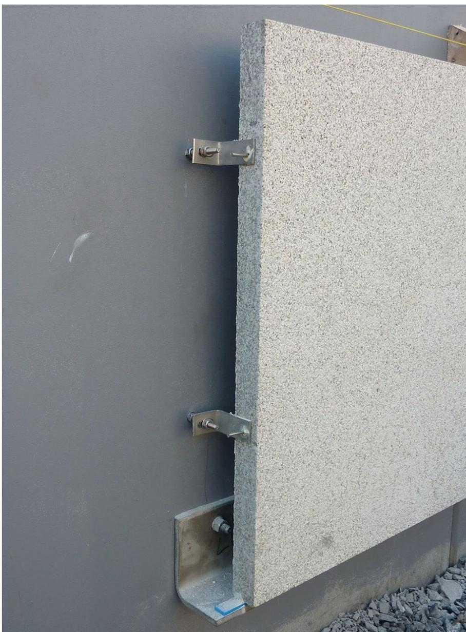
**Fig. 221**\_ Sistema de fixação indirecta para fachada por recurso a ancoragens laterais e um apoio secundário inferior. Cada cavilha estará associada a duas placas, lateralmente
