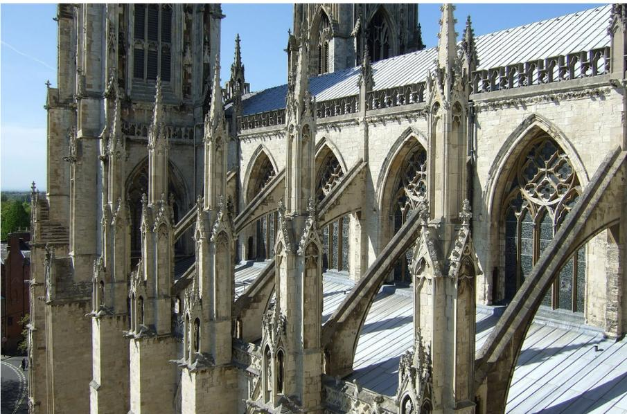
**Fig. 152** Catedral de Iorque, Inglaterra. Pormenor dos arcobotantes e contrafortes que exteriorizam a condução das cargas e permitem a abertura de grandes vão. Os contrafortes são travados com pináculos. A cobertura é revestida a folha de chumbo
