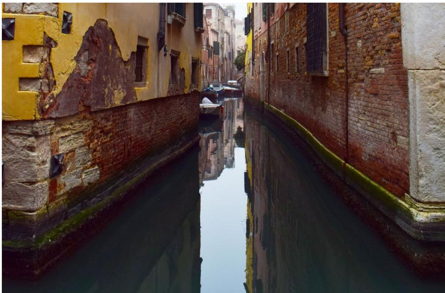
**Fig. 98**\_Canal de Veneza. As marcas de eflorescências e cristalização do sal são evidentes nas paredes de tijolo (descoloração branca) tal como a marca da água acima da pedra (humidade acima da descoloração verde da pedra)
