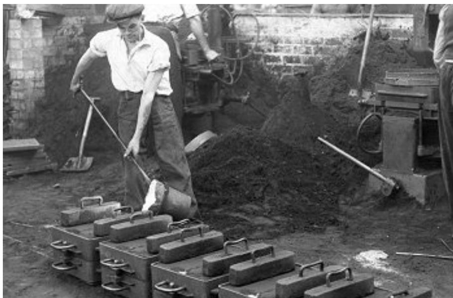
**Fig. 166** Operário a verter ferro fundido em moldes de areia
