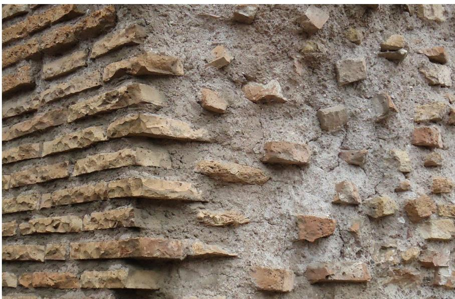
Fig. 136\_Construção de parede por opus caementicium: núcleo de cimento romano, cujo agregado é de tijolo, revestimento por tijolo em opus testaceum
