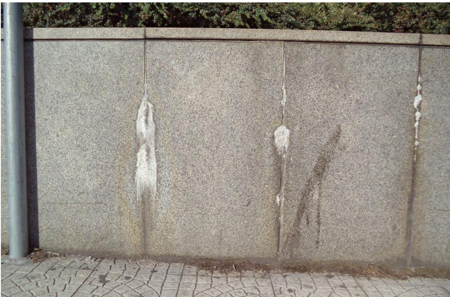
**Fig. 67**\_Concreções e manchas em placagem de granito no muro de canteiro, Edifício Tranquilidade, rua Júlio Dinis, Porto (2018)
