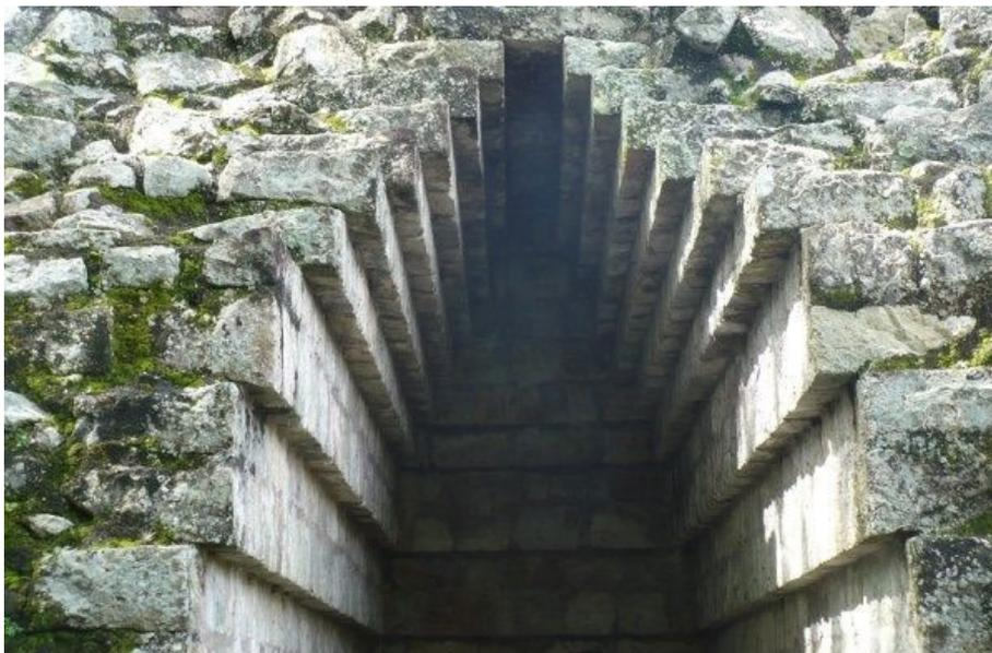
**Fig. 137**\_Arco maia. O arco ganha um recorte em forma de escadaria invertida pelos silhares colocados em consola consecutivamente
