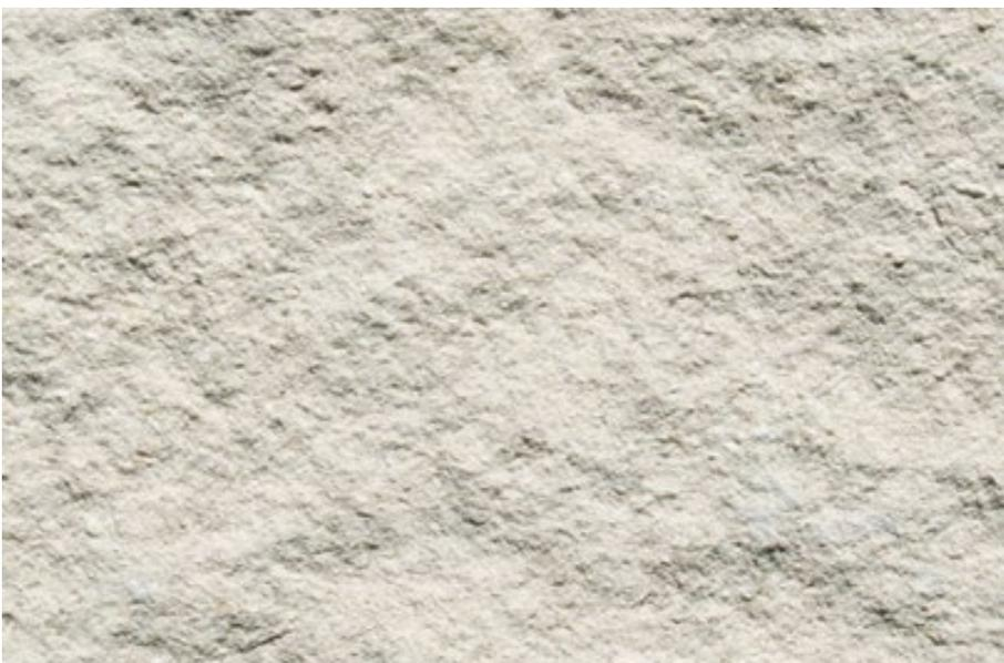
**Fig. 210**\_Acabamento escacilhado
