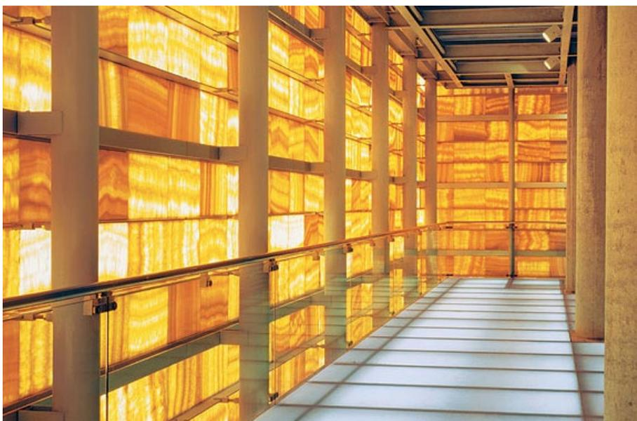
**Fig. 87** Vista interior do mezanino de ónix translúcido e do seu sistema de suporte amortecedor de impacto de explosões
