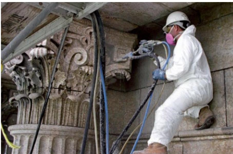
**Fig. 61**\_Limpeza de fachada pétrea e os seus elementos através de jacto de água de alta pressão
