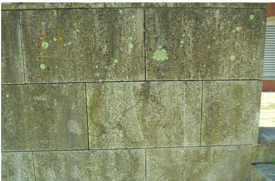
**Fig. 72**\_Descoloração, crostas, pátinas e colonizações biológicas na placagem de granito de muro virado a norte, rua interior da Faculdade de Letras, Porto (2018)
