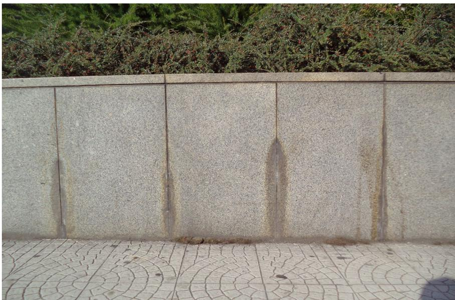
**Fig. 71**\_Manchas e descoloração das placas de granito devido ao fluxo de água do canteiro, Edifício Tranquilidade, rua Júlio Dinis, Porto (2018)
