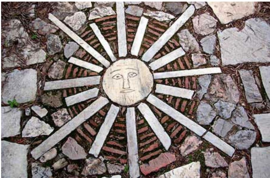
**Fig. 254** Figura do sol, detalhe da pavimentação que utiliza tijolo e diferentes tipos de pedra
