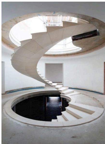
**Fig. 273\_**(esq.) Escalier Riddolfi, escada autoportante de compósito estrutural de pedra (reforçada por 3 cabos de aço internos) desenvolvida por Giuseppe Fallacara, 2005
