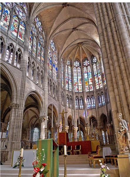
**Fig. 153** (esq.) Basilica de Saint-Denis, Paris. Note-se a exaltação da luz e do desenho de abóbada ogival derivada do arco quebrado, características da arquitectura gótica
