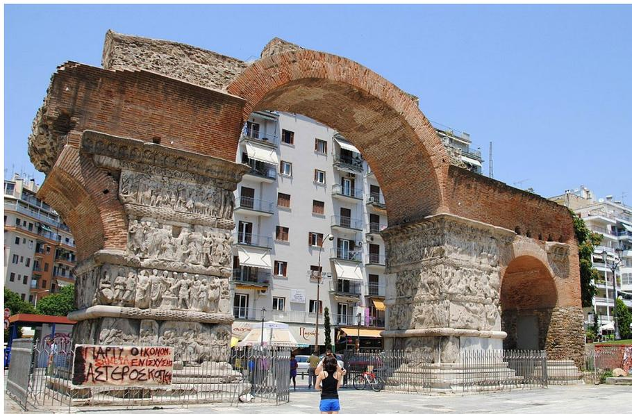
**Fig. 143** \_Arco de Galério, Tessalónica, Grécia, séc. IV. A estrutura evidencia o sistema construtivo romano da época: um núcleo de *opus caementicium* forrado a tijolo, *opus testaceum*, que é posteriormente revestido com placagem de pedra, mármore ou calcário, repleta de detalhes e narrativas, característico dos arcos triunfais
