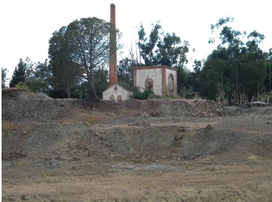
Figura 10 – Antigas infraestruturas mineiras e zona de escombreyra da Mina da Mostardeira.
