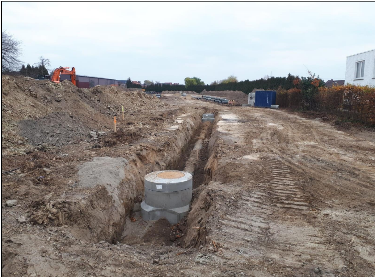
Afb. 17: Aangelegde riolering, foto genomen uit het westen (Bron: ARON bvba, dd. 20/11/2018).
