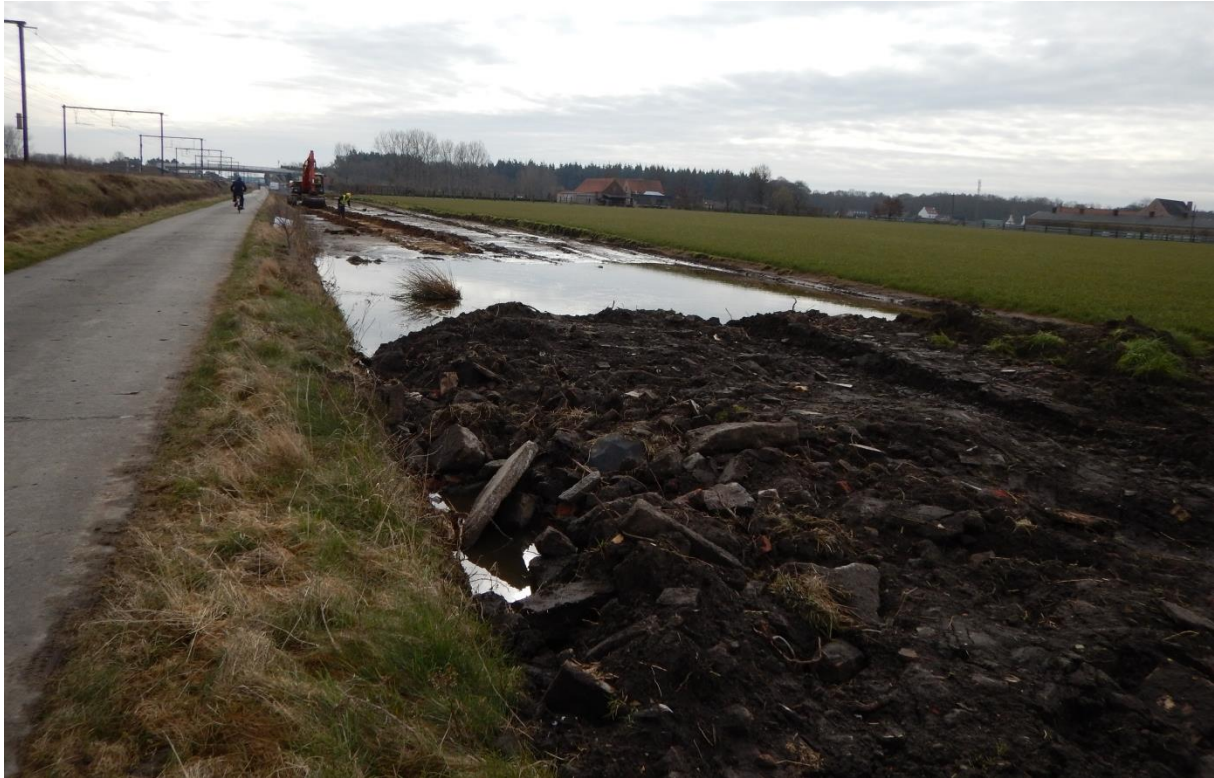
figuur 15 Zicht op de zone waar sleuf 18 aangelegd diende te worden.
