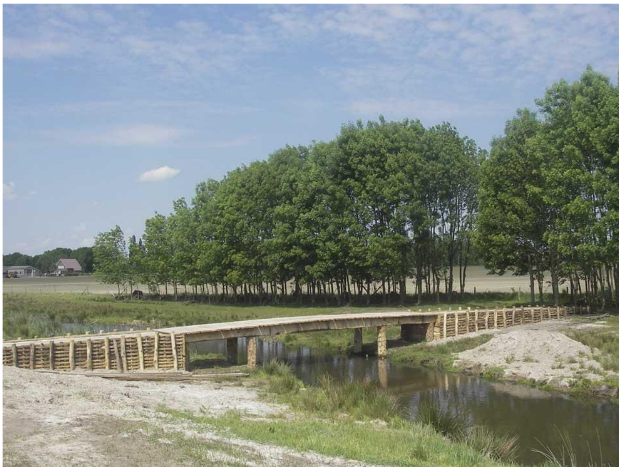
Figuur 45: Reconstructie van de gevonden Romeinse brug te Stamproy (@RAAP).
