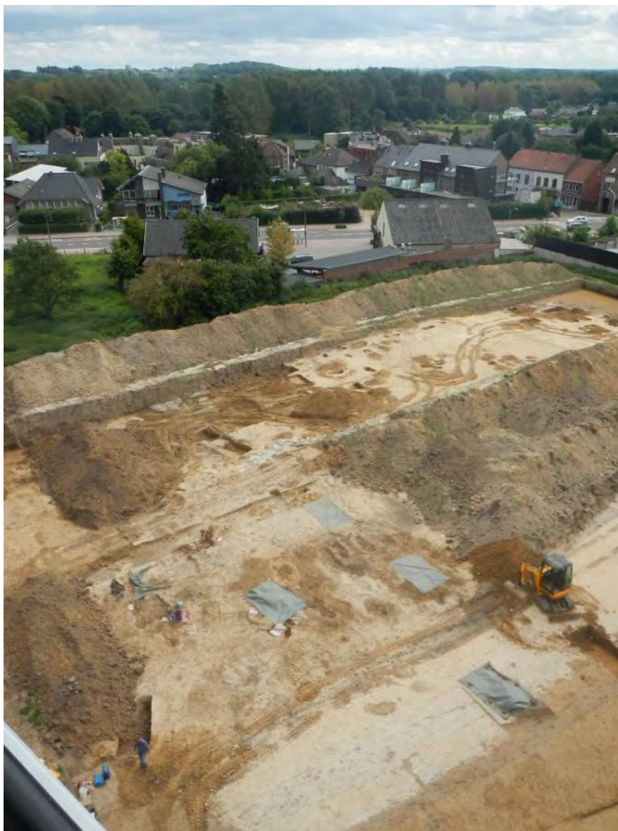
Afbeelding 116: Sfeerfoto genomen vanuit de bak van een laddervagen van de brandweer van Hoeselt. Op de voorgrond is duidelijk het opgravingssterrein zichtbaar. Op de achtergrond is het dal van de Demer zichtbaar.
