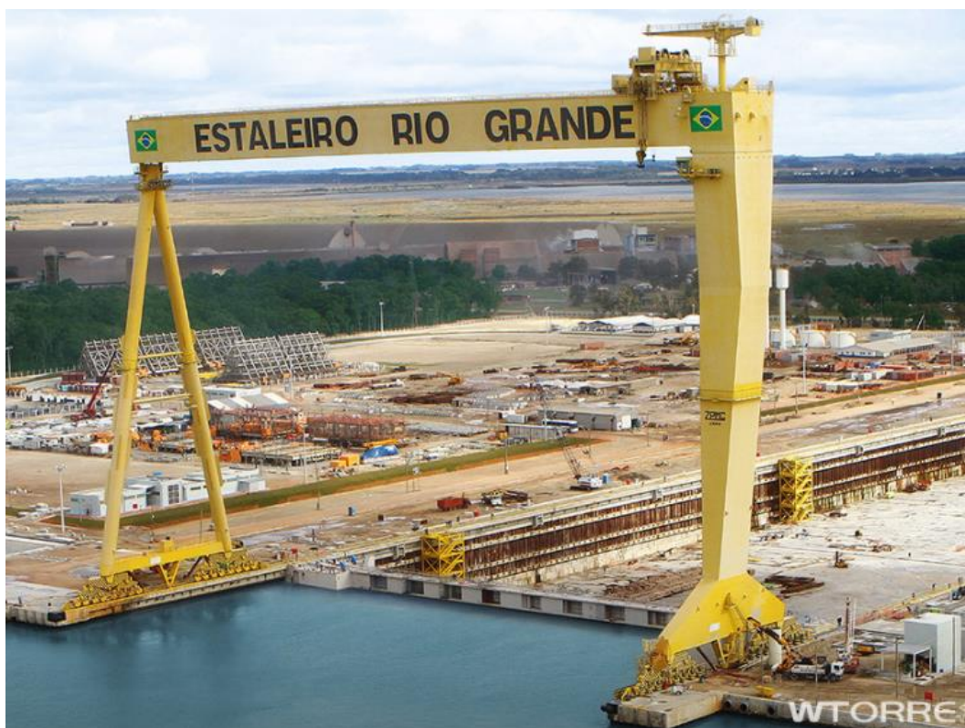
Figura 01 - Pórtico Rolante no Estaleiro Rio Grande
