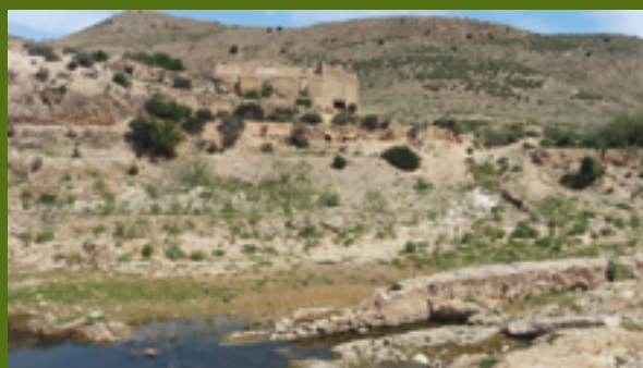
Galería antiguamente construida en el subsuelo de la rambla
