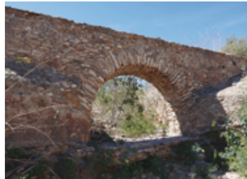
Acueducto que salva el Ramblizo del Espinar
