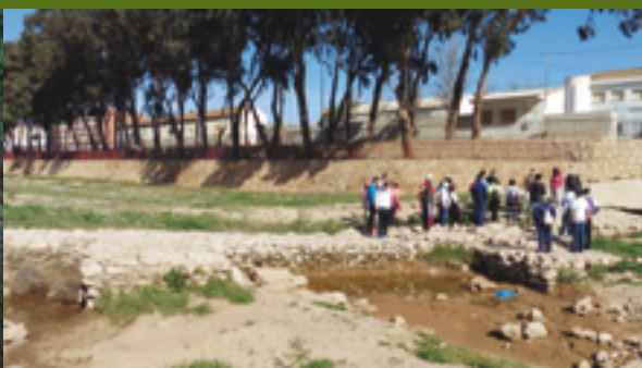
Presa subálvea en el lecho de la rambla
