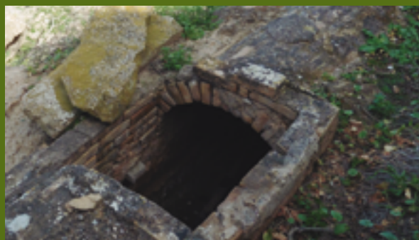
Lumbrera en galería de bóveda de cañón
