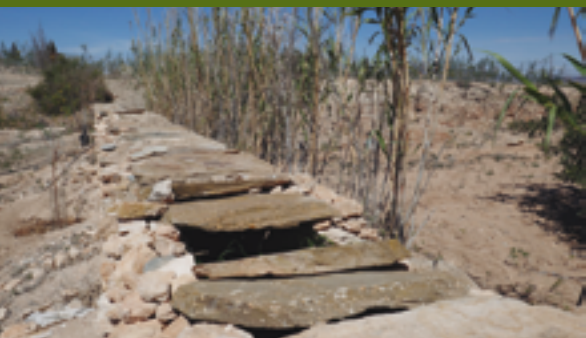
Acequia del siglo XIX cubierta con lajas de pizarra
