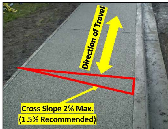
Figure 11: PAR Cross Slope
