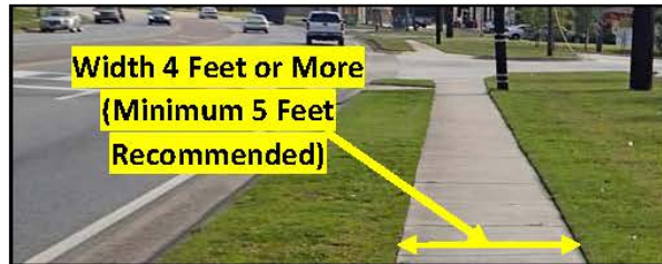
Figure 3: PAR Continuous Width
