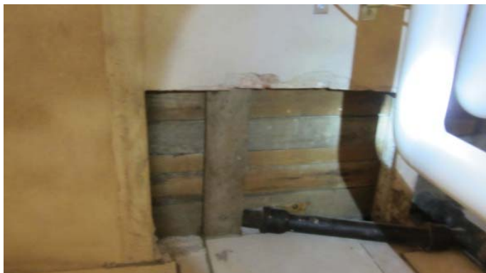
Kuva 15. Ensimmäisen kerroksen välipohjarakenne on i-teräspalkkien varaan muurattu kaariholvi, jonka yläpuolella on puukoolaus.
