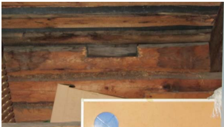
Kuva 19. Yläpohjan ullakkotilan tuulettuvuutta on parannettu ulkoseinärakenteeseen tehdyillä tuuletusaukoilla.
