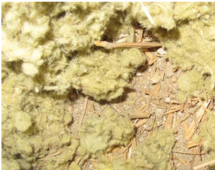
Kuva 5. Pohjoissiiven yläpohjan lämmöneristeenä on hiekkaa ja olkea sekä puhallusvillaa.
