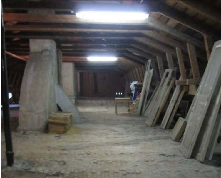
Kuva 6. Kuvassa on keskiosan ullakkotila ja tiilimuurattu palopermanto.
