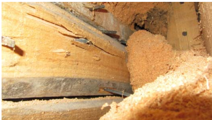
Kuva 14. Neljännen kerroksen lapeosan seinärakenteessa on sahanpurueristys.
