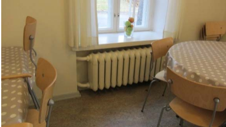
Kuva 18. Ensimmäisen kerroksen seinärakenne on osaksi maanvastainen ja siinä on patterisyvennys, jonka rakenne ei ole tiedossa.
