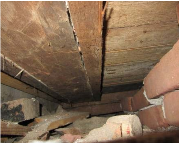
Kuva 7. Kellarin putkikanaalin kautta tarkasteltuna kantava alapohja on puurakenteinen.
