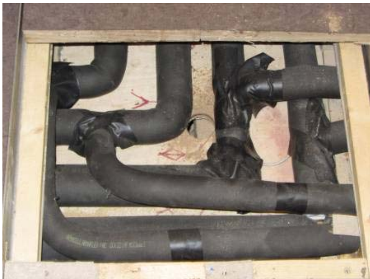
Kuva 8. Työhuoneen lattiarakenteessa on lämpöputkikanaali.
