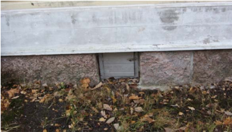
Kuva 21. Kantavan alapohjan ryömintätila tuulettuu perusmuurissa olevien tuuletusaukkojen kautta.
