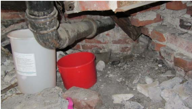
Kuva 12. Rappukäytävän kupolikatteen rakenteiden liitos- ja vauriokohdista valuu vettä sisätiloihin.
