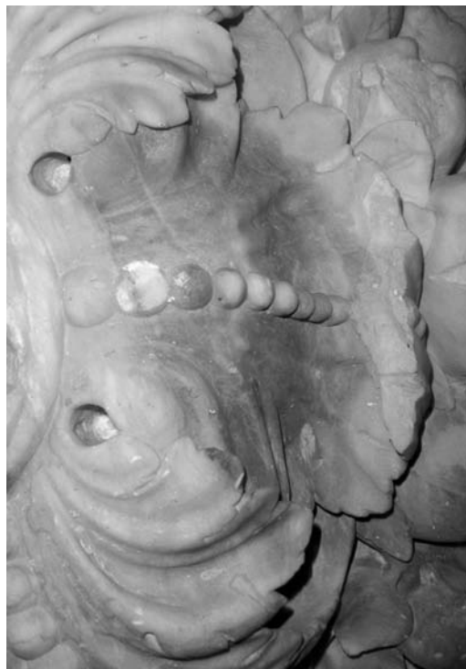
Aspecto visual de las pátinas de oxidación. Pátina de oxidación 7 situada en el primer piso. Escala: lápiz, 14.5 cm. (Fotografía: Elisabet Playà).
