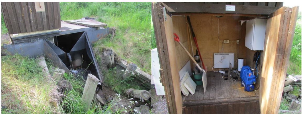
Kuva 10. Ylivirtauspato ja mittalaitteita Teeressuonojan mittausasemalla.
