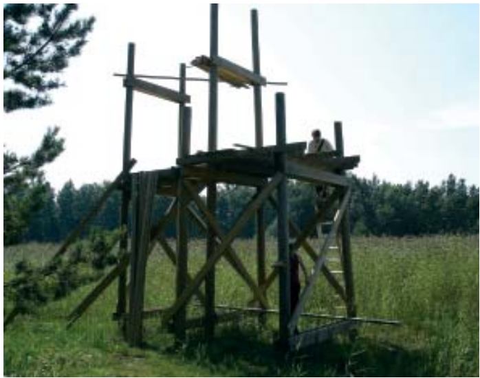
Rakenteilla oleva lintutorni. Långvassöfjæden, Inkoö. Valokuva: Mauri Karonen.
