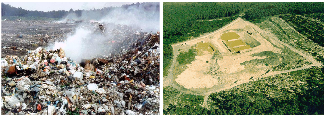
Fig. 4.4 – (Esquerda) Deposição de RSU na lixeira de Maceda (1991), situação que ocorreu durante cerca de 20 anos. (Direita) Vista aérea do processo de selagem da lixeira (arquivo da Câmara Municipal de Ovar, 1999).
