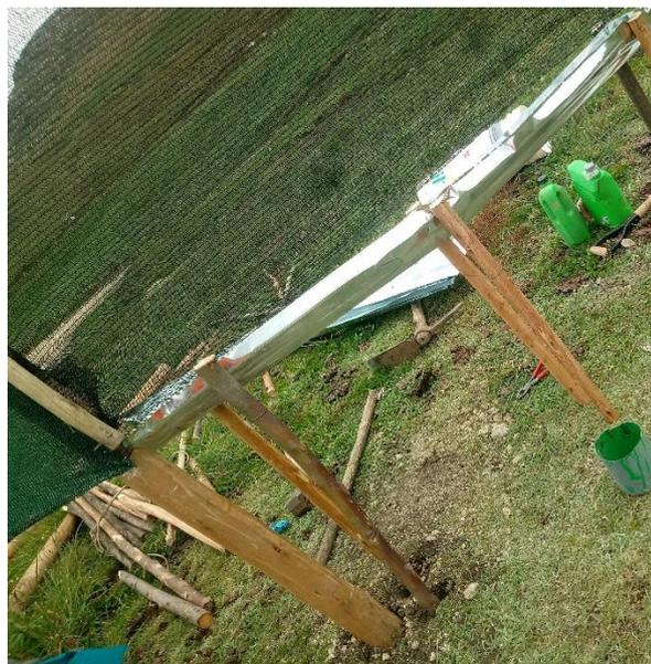
*Figura 9.* Estacas colocadas, sujetando la calamina que cumplirá la función de conducir el agua captada hacia el recipiente.
