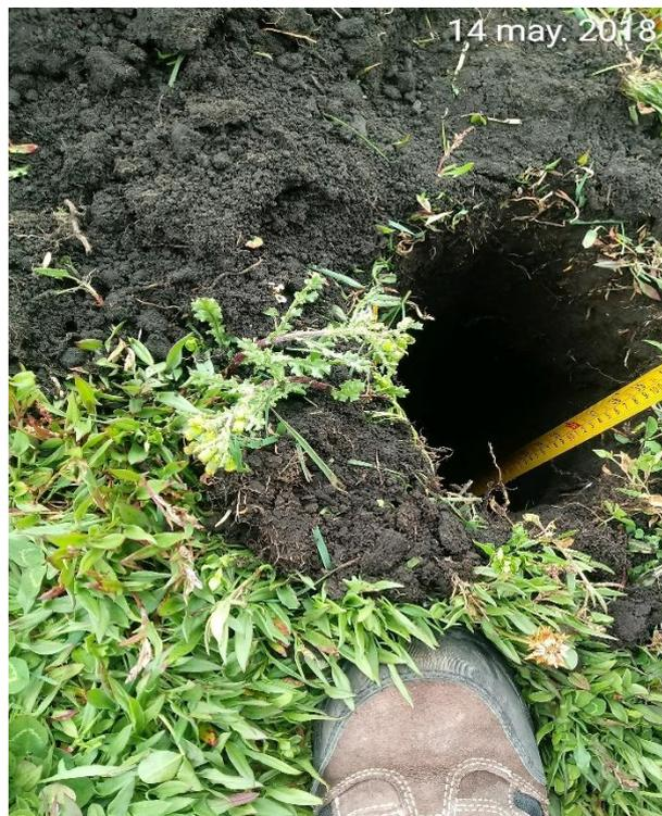
*Figura 3.* Medición de 1 metro de profundidad del hueco en el cuál se colocará los postes.
