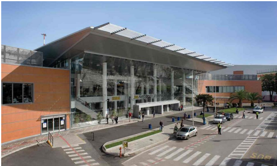
Fig. 82 Curb dell'aeroporto di Napoli
