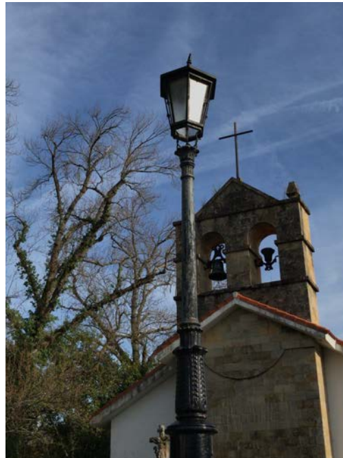
Imagen 5.8: Luminaria AP01. Fuente: Elaboración propia.
