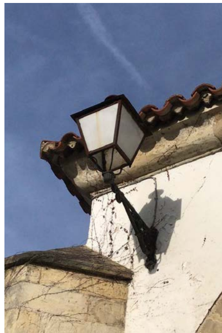
Imagen 5.7: Luminaria AP01. Fuente: Elaboración propia.
