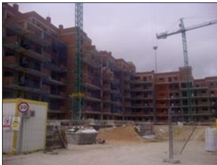
Fig. 11. Vista Frontal del edificio en construcción (1).
