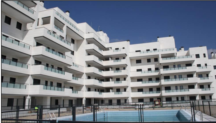
Fig. 5. Bloque de viviendas de la cooperativa Arroyo Bodonal en Tres Cantos (Madrid), considerado de consumo de energía casi nulo.
