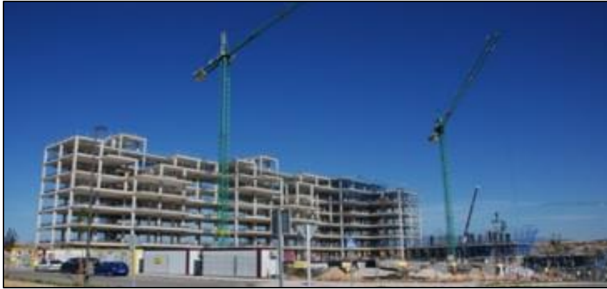
Fig. 12. Vista Frontal del edificio en construcción (2).
