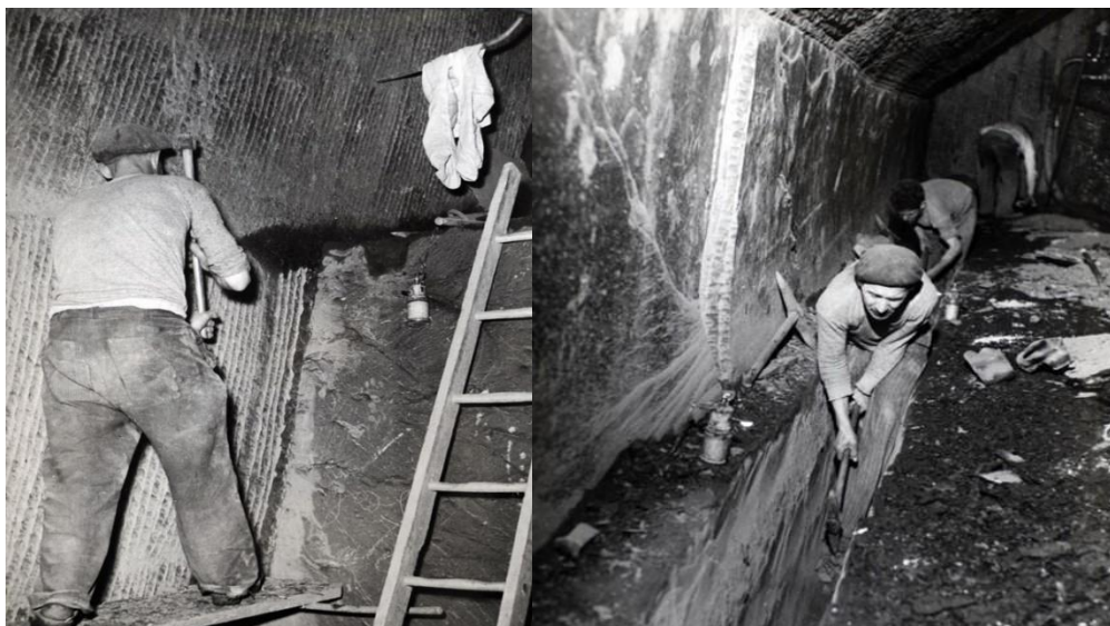
Figura 2.8 Abertura de corte e vala manual em exploração subterrânea (anos 50, Arquivo Municipal de Valongo).
