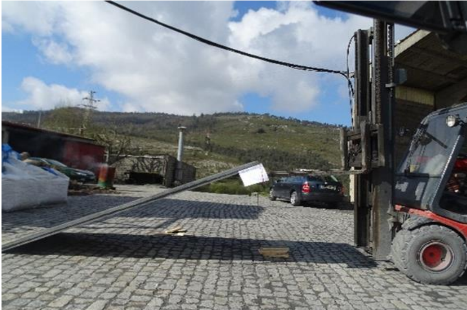
Figura 5.4 Realização de ensaio de tilt-test na pedreira da Milhária.
