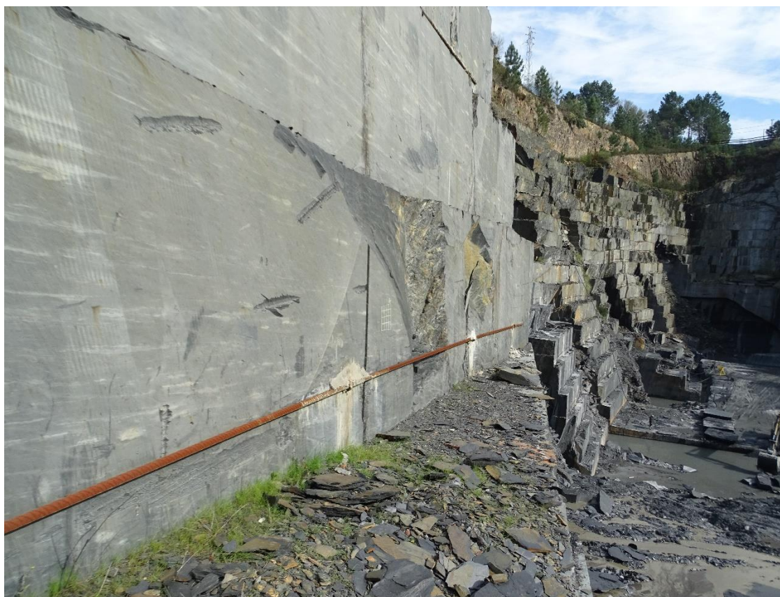
Ilustração 1.4 Vista lateral do talude estudado
