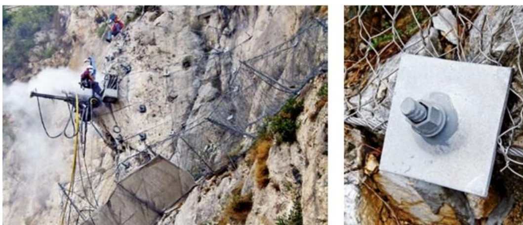
Figura 7.1 Estabilização de talude rochoso ( https://www.dywidag-systems.pt/fileadmin ).
