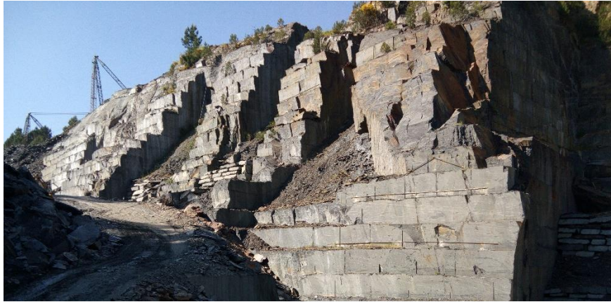
Figura 2.15 Detalhe da atual exploração da ELV (autor).
