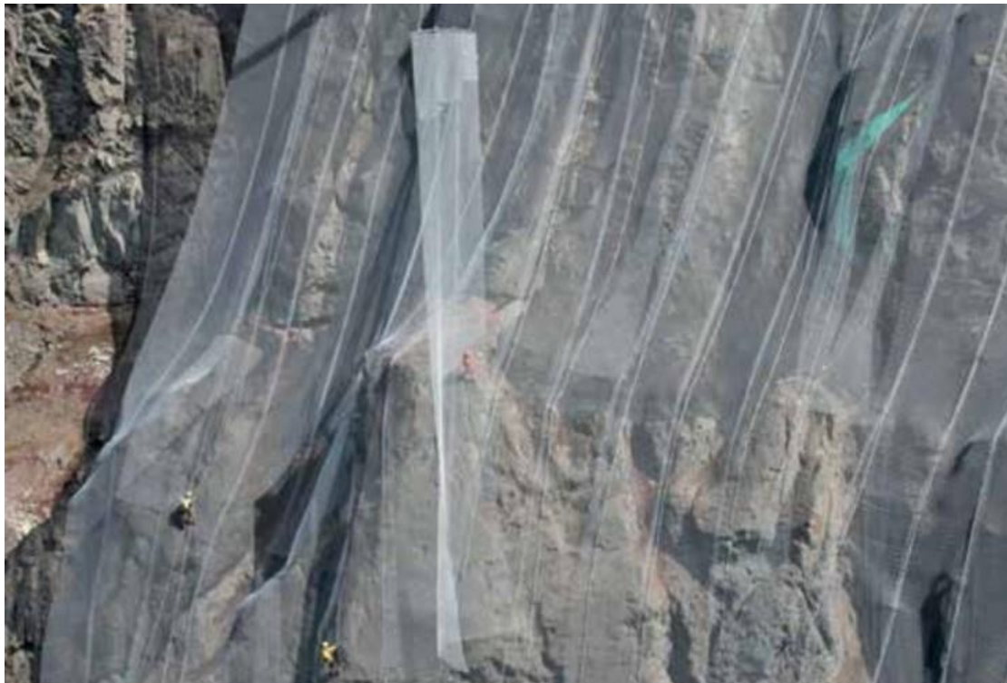
Figura 7.4 Redes de aço: Cortina atenuadora (www.geobrugg.com).
