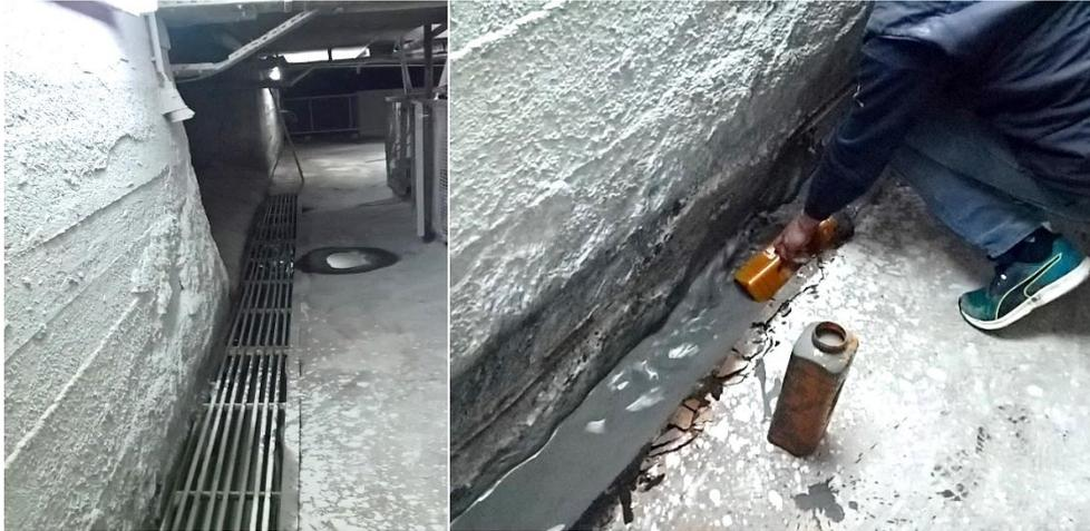
Figura 36 - Local de recolha de amostras 1 – Grelha de escoamento que recebe o expurgo das lamas.
