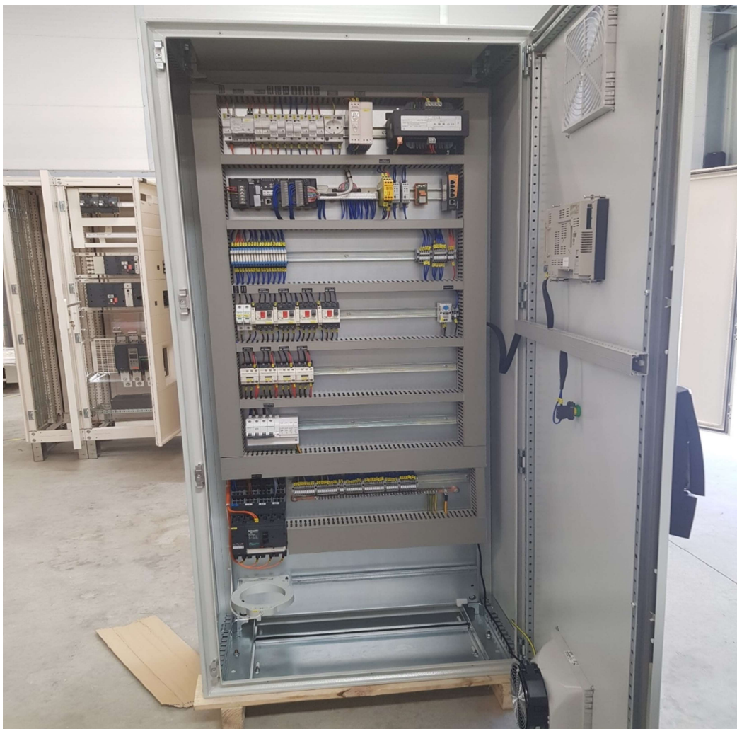
Figura 22 - Ventilação Mecânica através de ventilador
