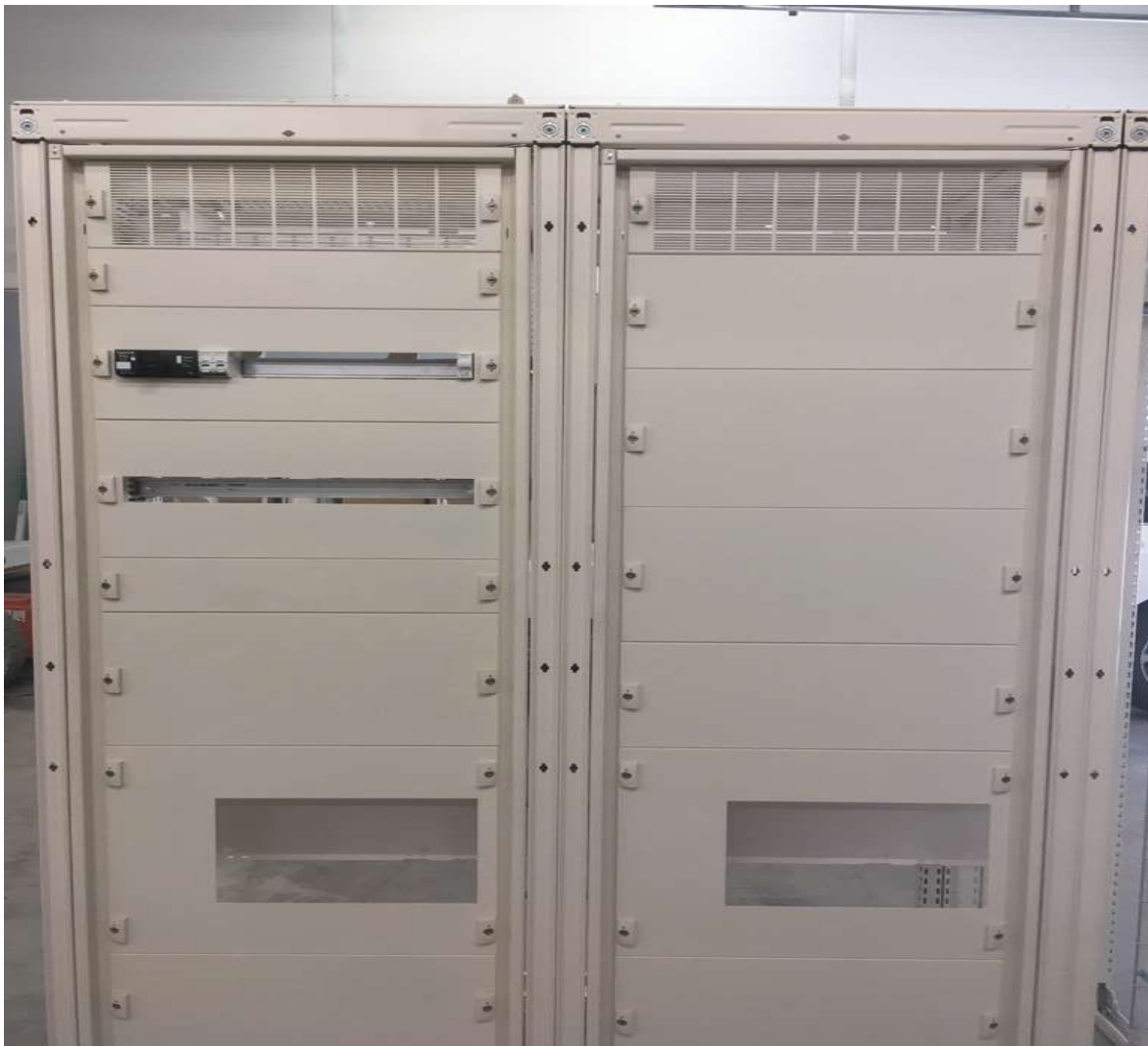
Figura 21 - Ventilação Natural através de grelhas
