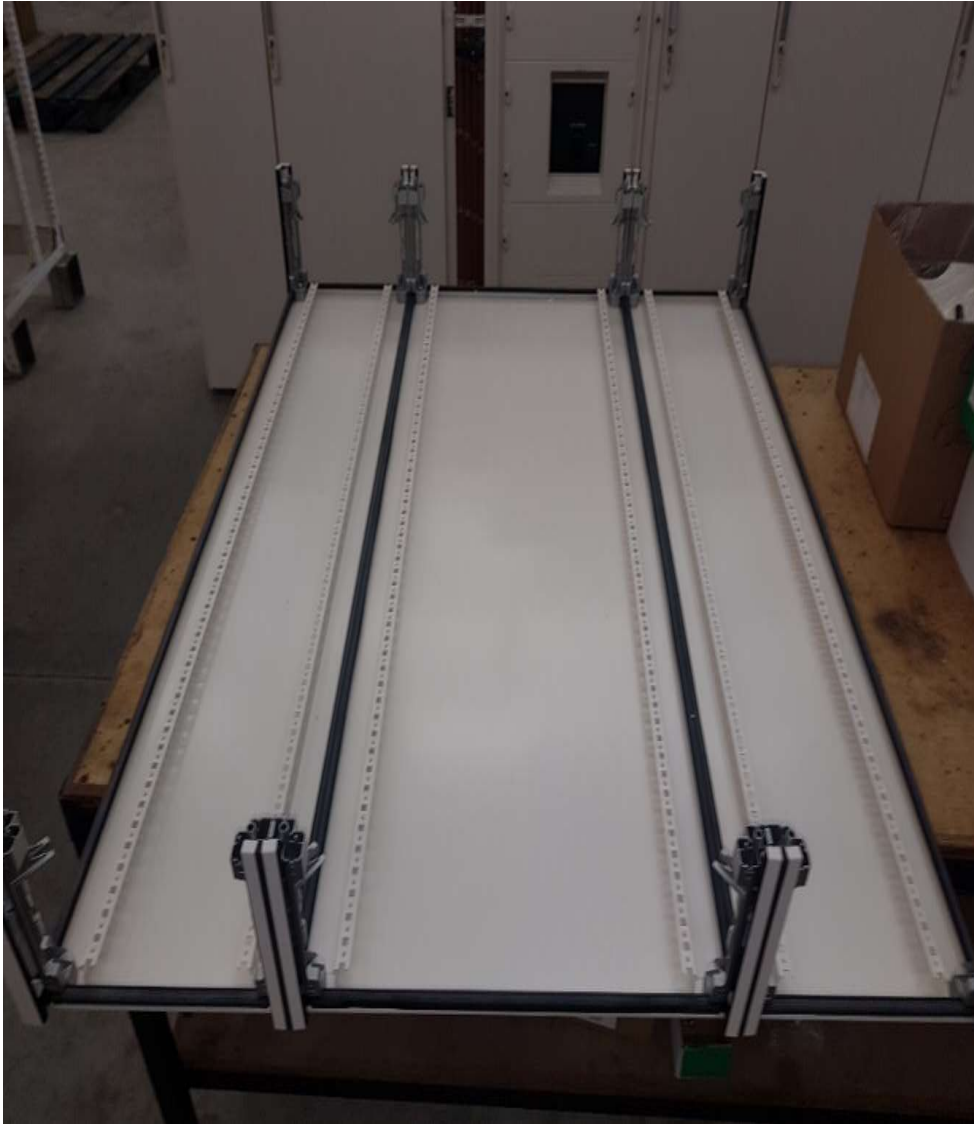
Figura 34 - Montagem da estrutura
