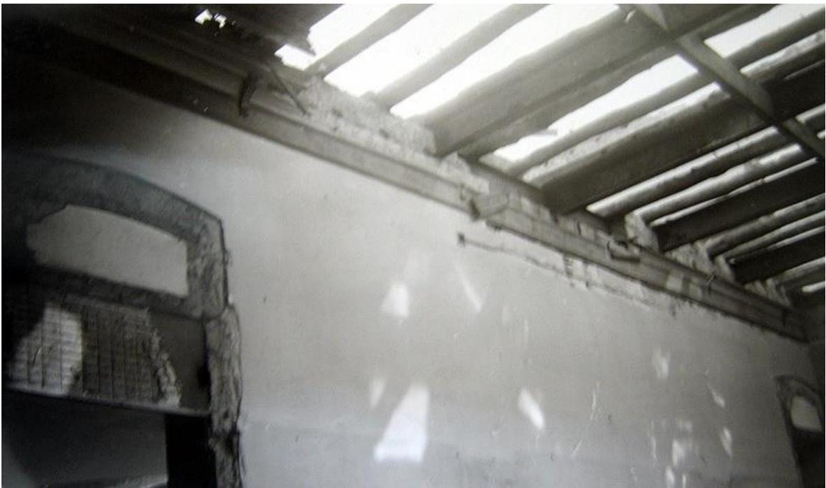
**Fig. 43** – [Processo de demolições interiores: estrutura do teto e acessos num dos salões voltados ao Jardim do Cinema Trindade], [1956-195?]. Reprodução digital de prova fotográfica de autoria desconhecida. Coleção Particular Margarida Neves. Fonte: [OP SIS-FLUL](#)
