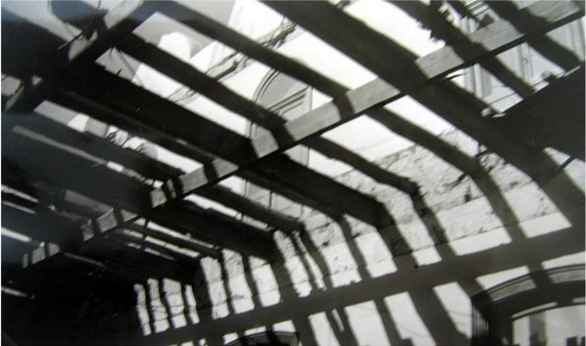
**Fig. 42** – [Obras de remodelação relativas à licença de obras n.º 515/1956: pormenor da varanda já desmantelada ao nível do primeiro piso da fachada do Cinema Trindade voltada ao Jardim], [1956-195?]. Reprodução digital de prova fotográfica de autoria desconhecida. Coleção Particular Margarida Neves. Fonte: [OP SIS-FLUL](#)
