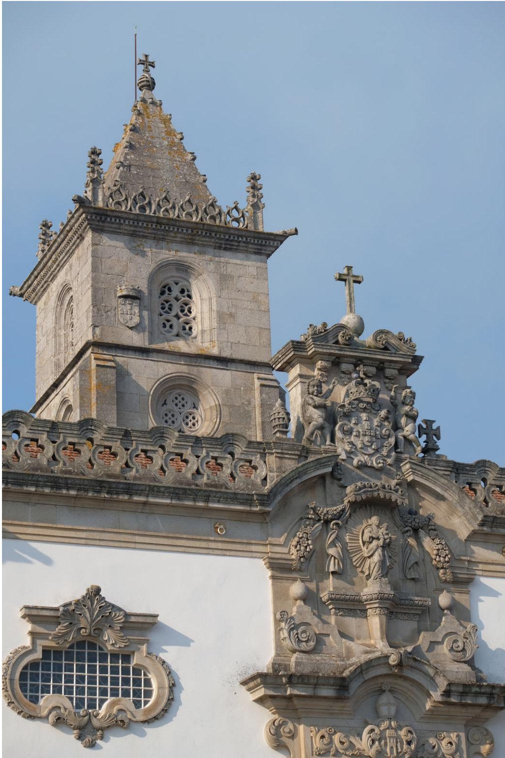
Fig. 215 – Pormenor da fachada principal e torre sineira
