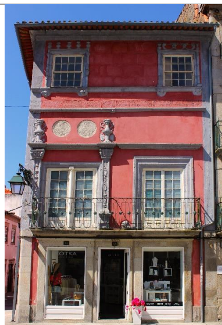
Fig. 151 – Pormenor da fachada principal
