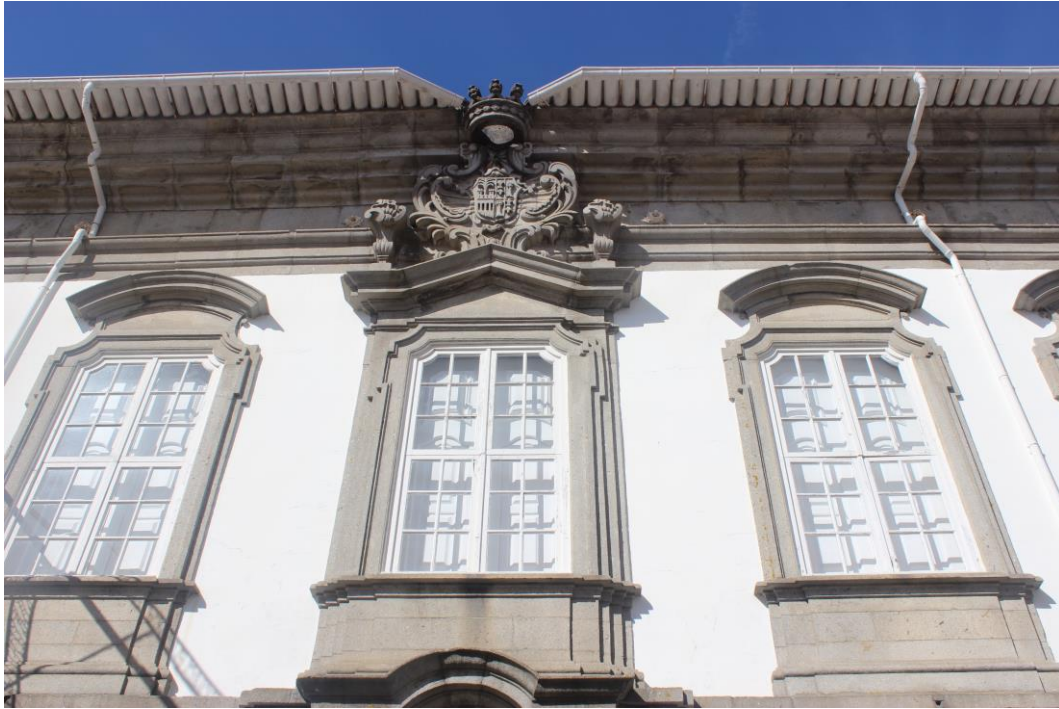
Fig. 288 – Pormenor da fachada principal
