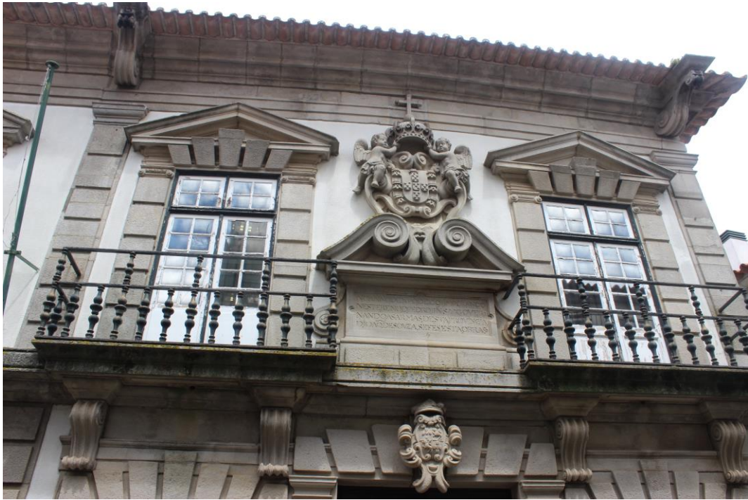
Fig. 279 – Pormenor da fachada principal da Casa da Vedoria
