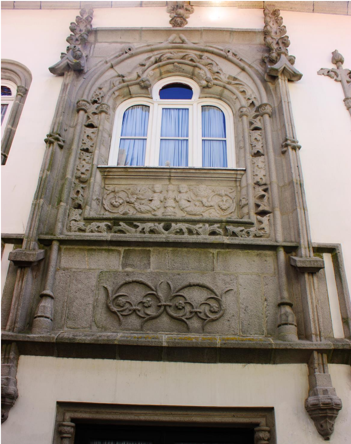
Fig. 260 – Pormenor da janela central
