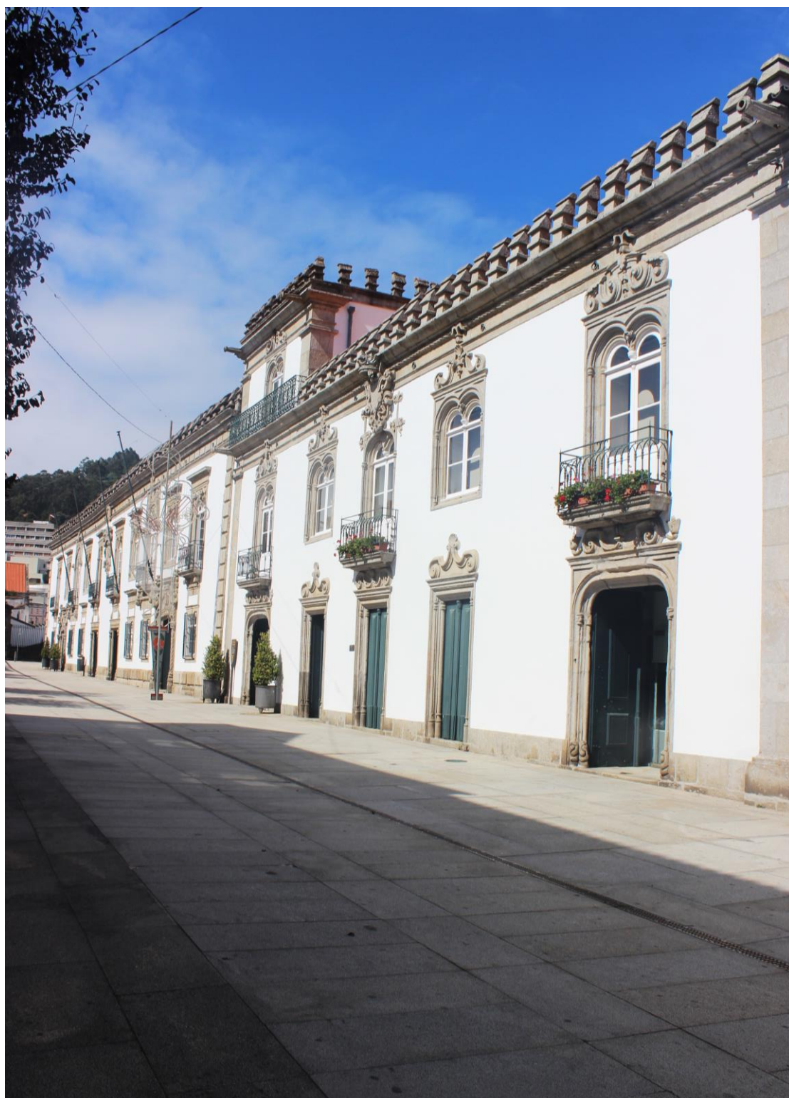
Fig. 264 – Casa dos Alpuim, enquadramento
