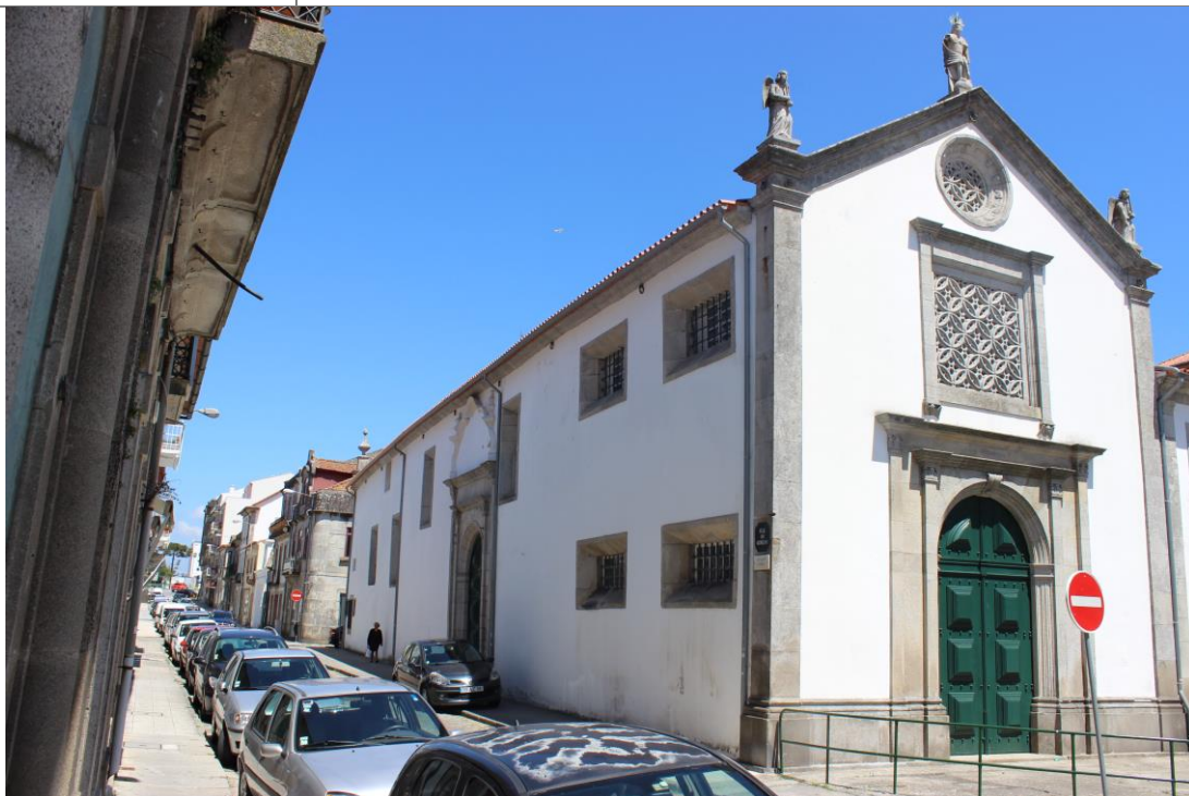
Fig. 61 – Igreja do Convento de São Bento
