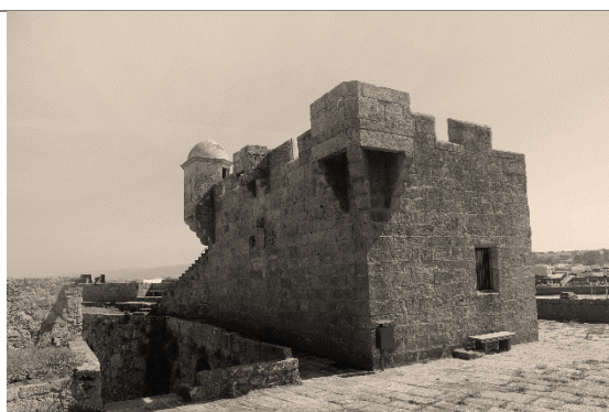
Fig. 10 – Torre da Roqueta
