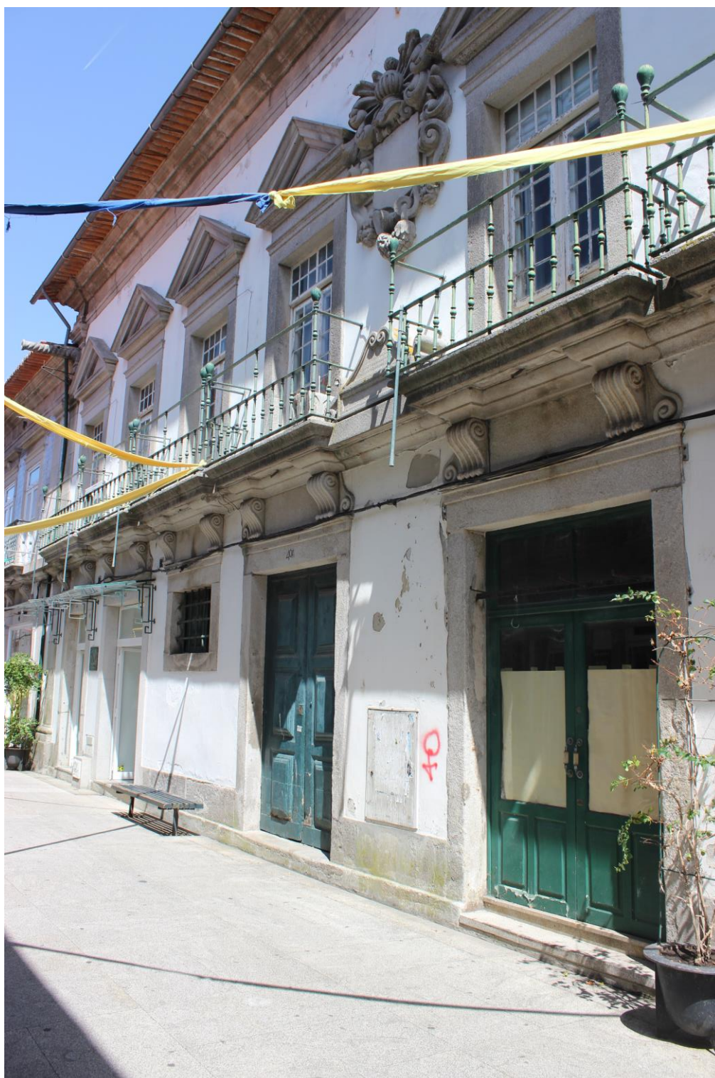
Fig. 284 – Pormenor da fachada principal da Casa dos Pimenta da Gama
