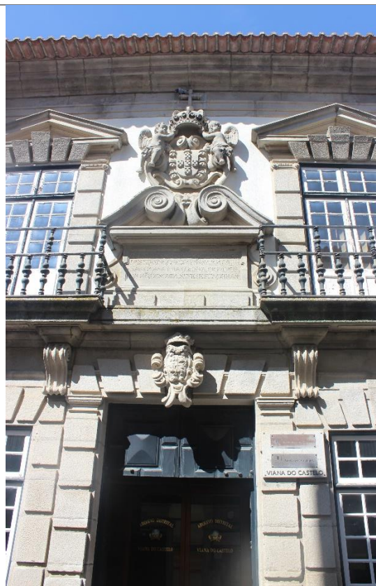
Fig. 164 – Pormenor da fachada da Casa da Vedoria
