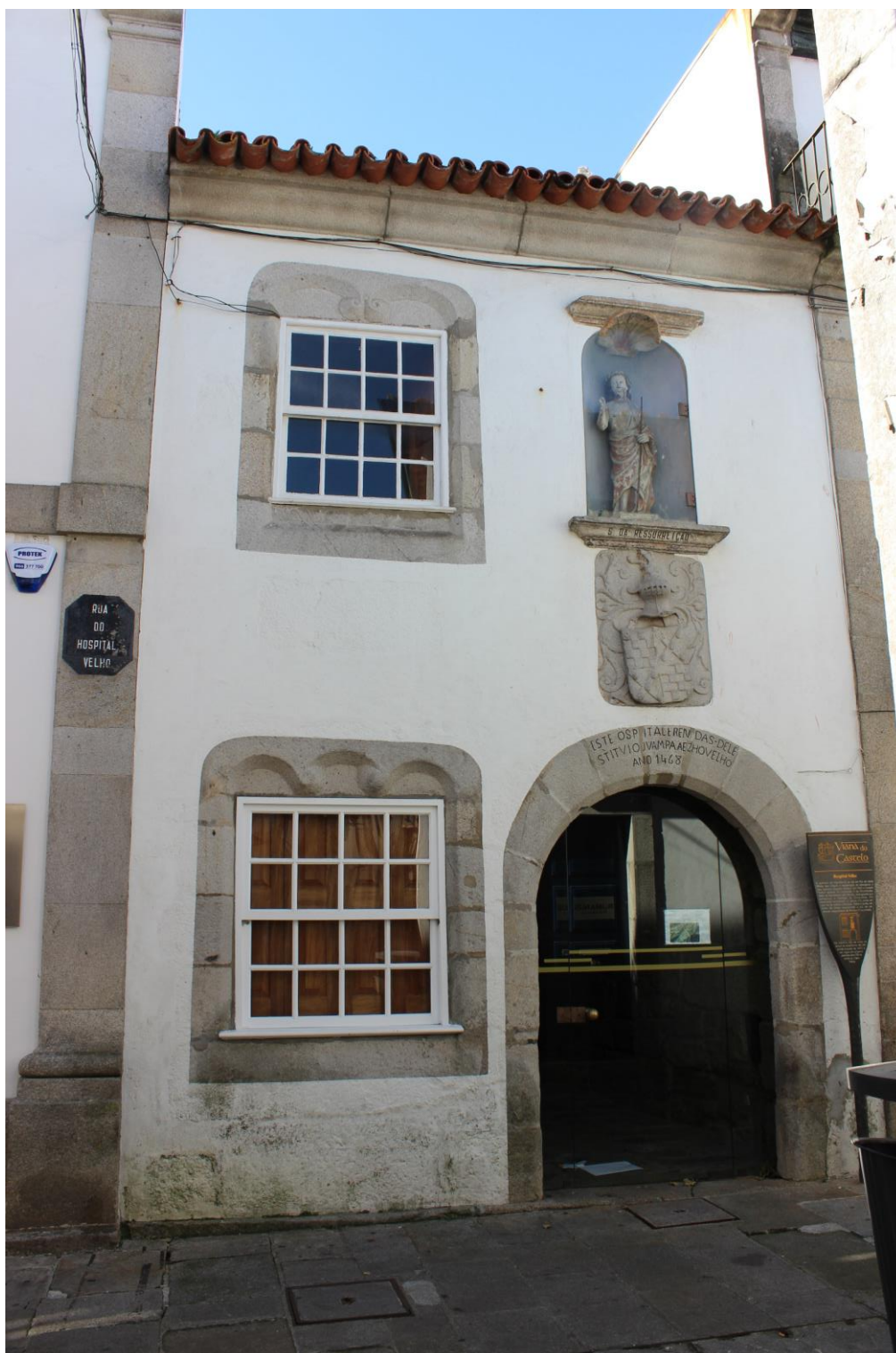
Fig. 257 – Casa do Hospital Velho
