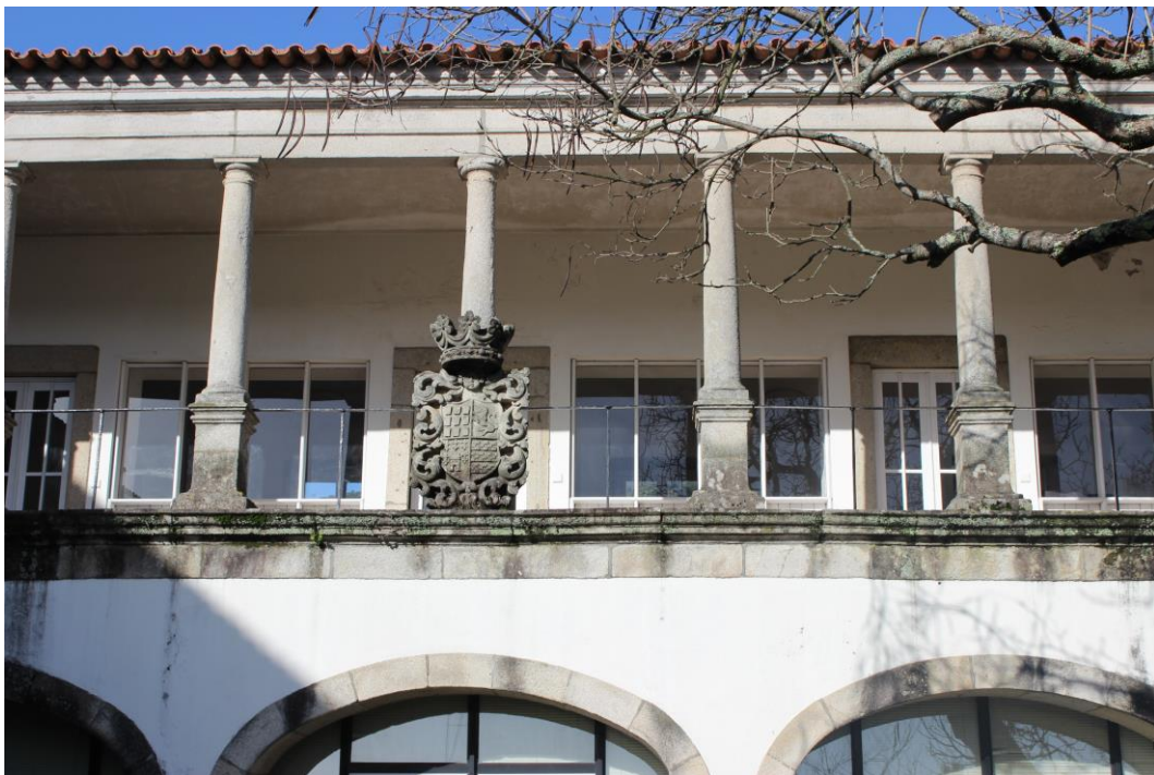
Fig. 242 – Pormenor da varanda exterior
