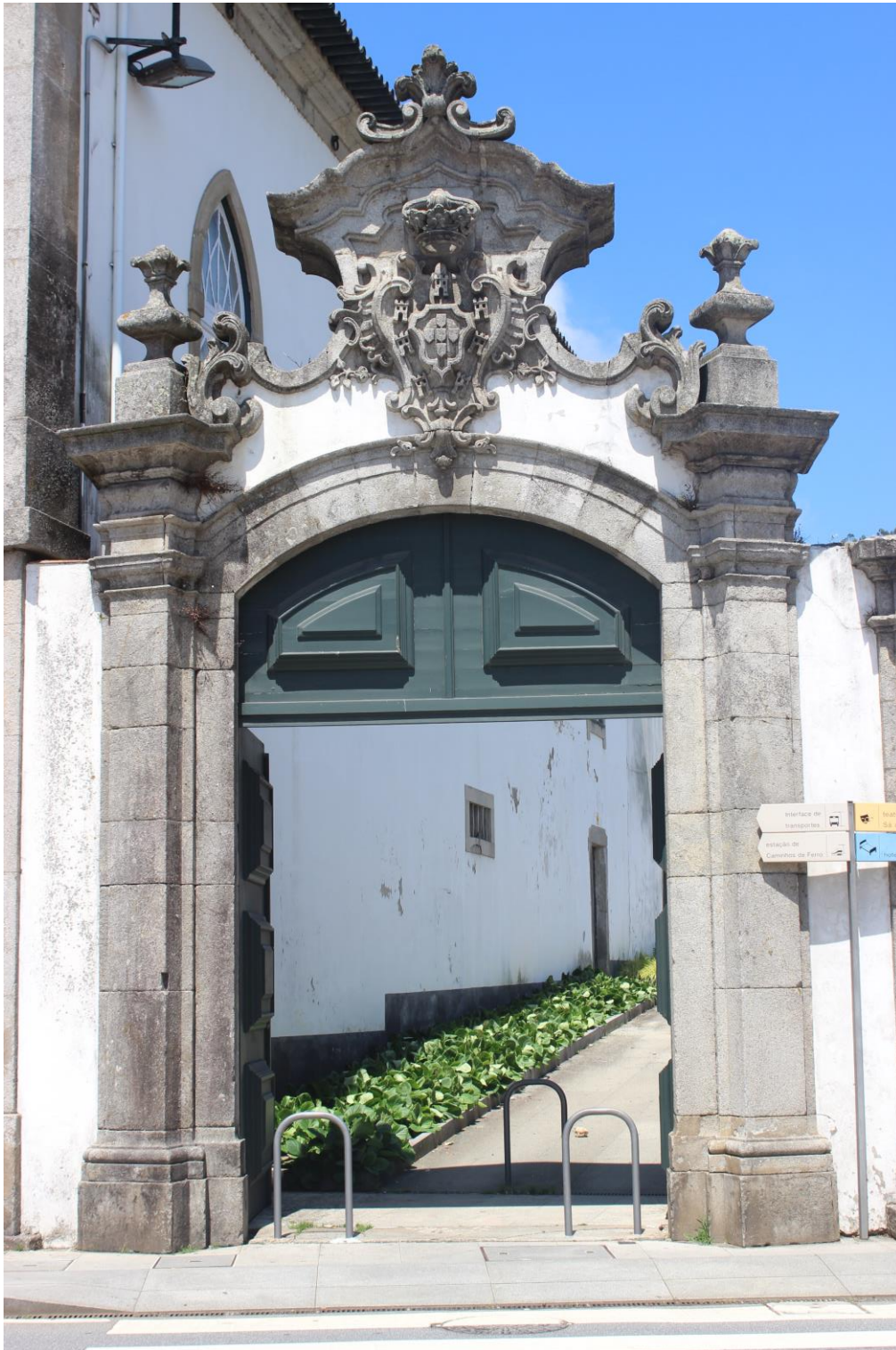
Fig. 296 – Portal lateral de acesso à quinta da Casa dos Werneck
