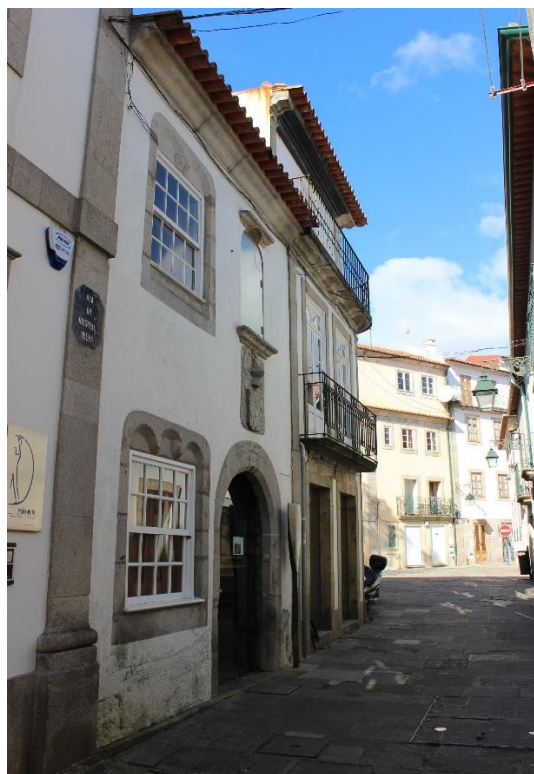
Fig. 120 – Enquadramento da Casa do Antigo Hospital
