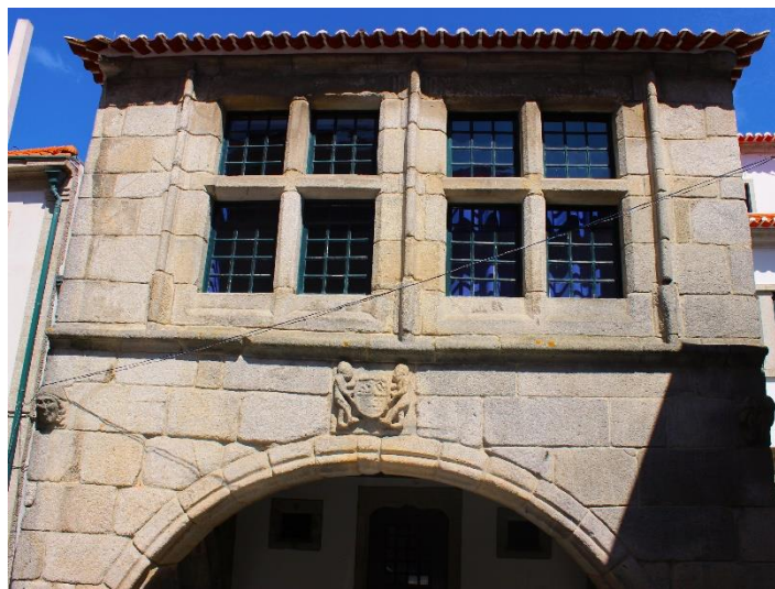
Fig. 118 – Pormenor da fachada principal
