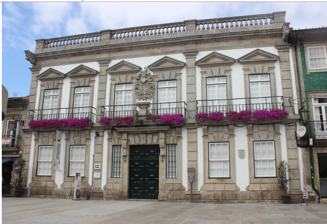
Fig. 167 – Fachada principal da Casa Barbosa Maciel
