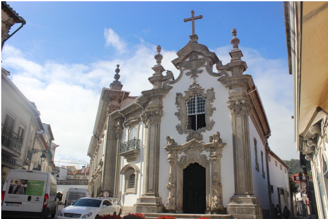
Fig. 289 – Capela da Casa da Praça
