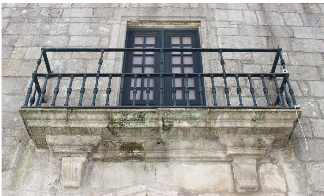
Fig. 298 – Varanda da fachada lateral
