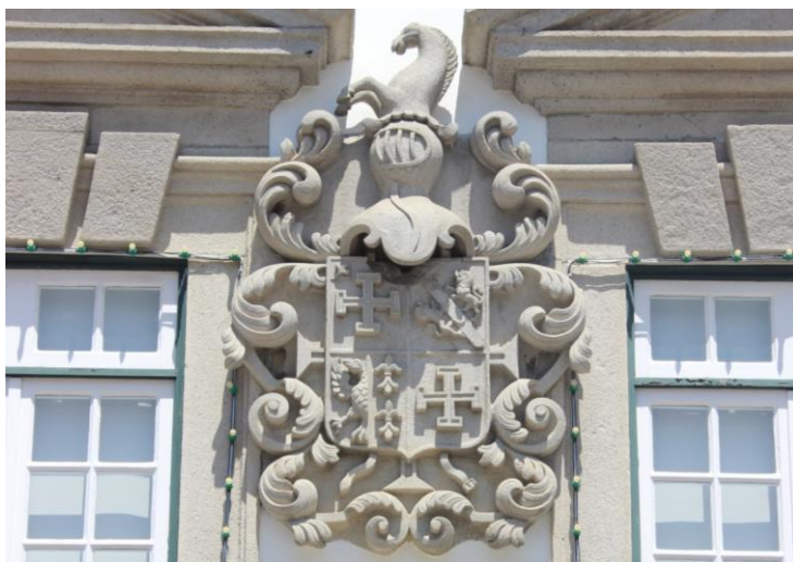
Fig. 169 – Brasão dos Teixeira Barbosa Maciel, na fachada
