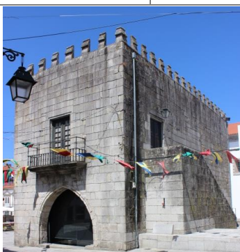
Fig. 194 – Fachada lateral e posterior
