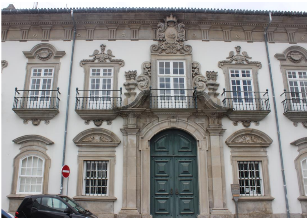
Fig. 291 – Pormenor da fachada da Casa dos Cunhas
