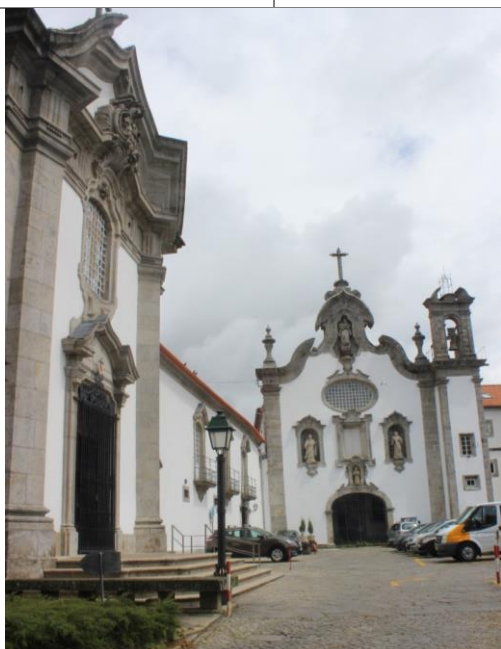
Fig. 91 – Vista geral do complexo conventual e capela da Ordem Terceira
