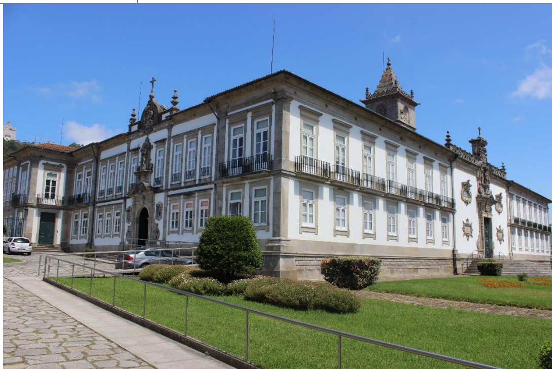
Fig. 37 – Convento de Santa Ana
