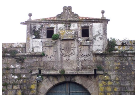
Fig. 4 – Pormenor da Porta da Praça, com arco de volta perfeita e aduelas em cunha rematado por cornija e lápide inscrita, encimada por três pedras de armas – ao centro as armas de Portugal e dos lados as armas de D. Diogo de Lima
