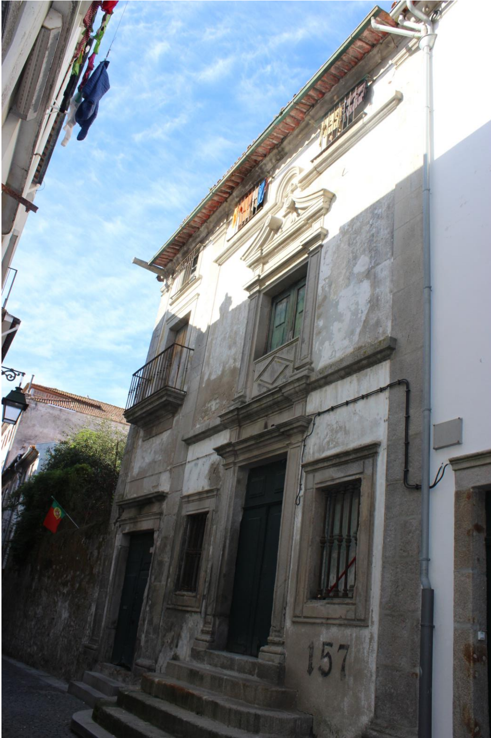
Fig. 285 – Capela da Casa dos Pimenta da Gama
