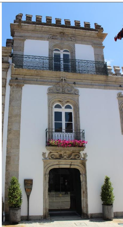
Fig. 144 – Pormenor da fachada, zona do torreão
