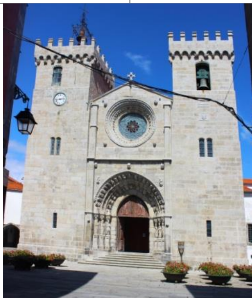
Fig. 23 – Fachada principal da Sé Catedral de Viana do Castelo
