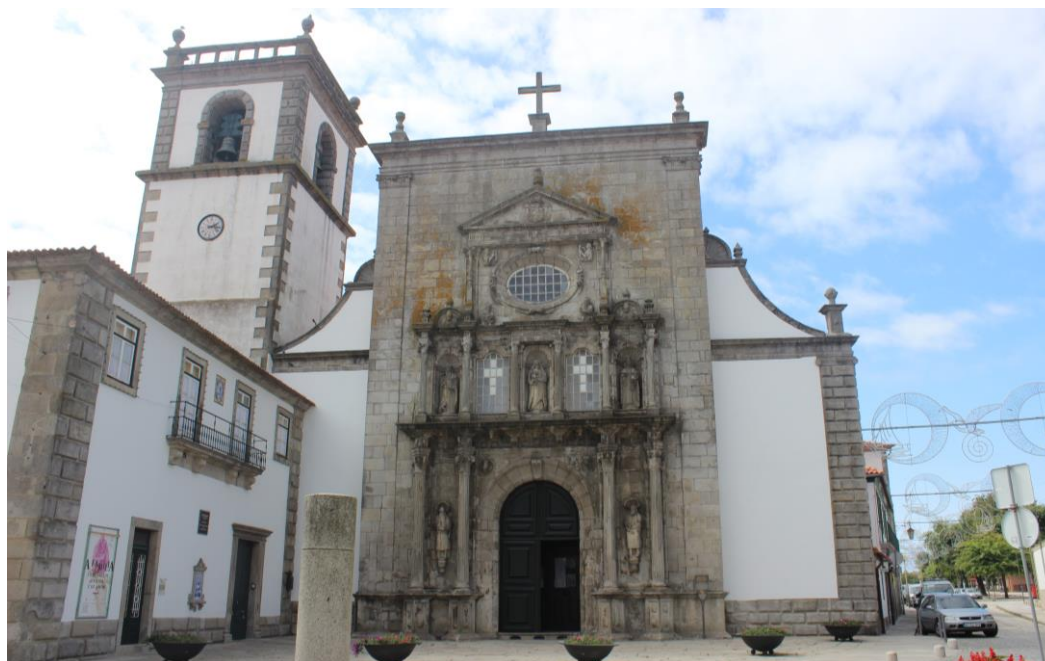
Fig. 67 – Igreja e Convento de São Domingos
