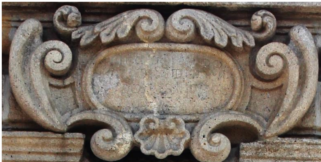
Fig. 132 – Inscrição, na fachada principal
