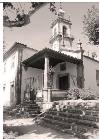
Fig. 100 – Capela de N. Sr a da Conceição da Rocha, anexa à sacristia da Igreja de N. Sr a da Agonia
