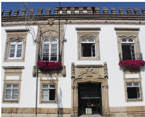
Fig. 142 – Pormenor da fachada principal
