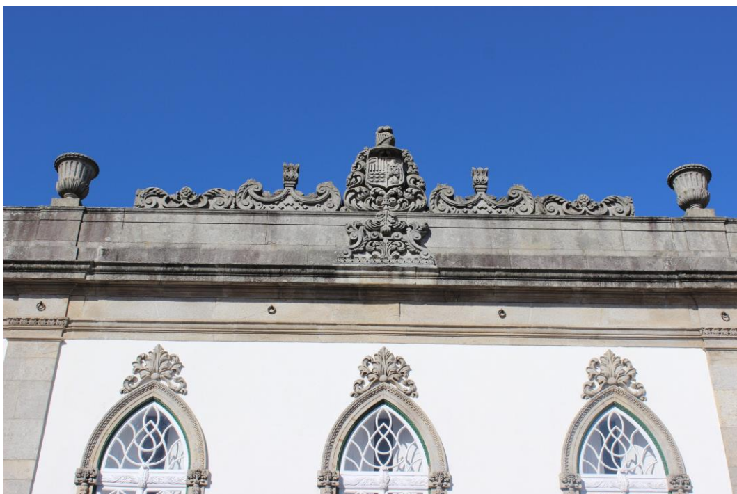
Fig. 295 – Pormenor da fachada principal
