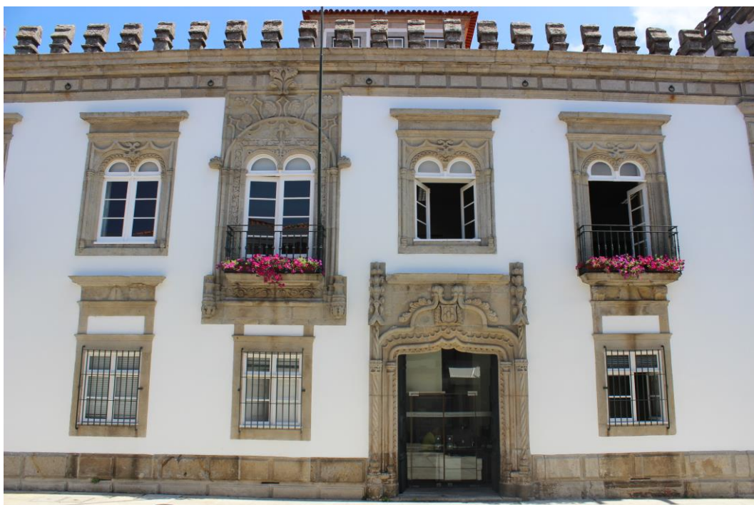
Fig. 262 – Pormenor da fachada principal
