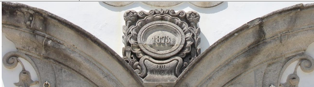
Fig. 95 – Inscrição na fachada principal
