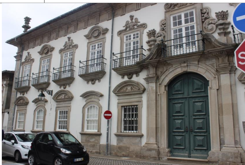
Fig. 183 – Pormenor da fachada principal
