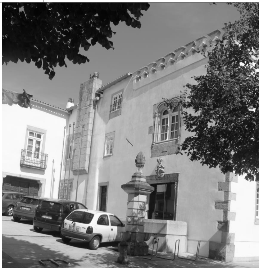
Fig. 149 – Fachada poente da Casa dos Melo Alvim
