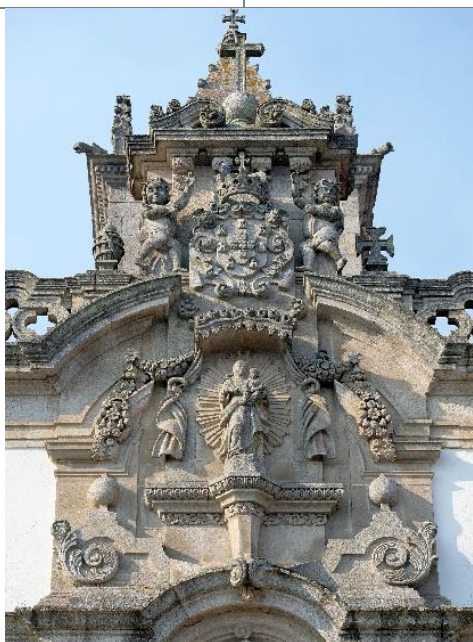
Fig. 44 – Brasão, fachada principal
