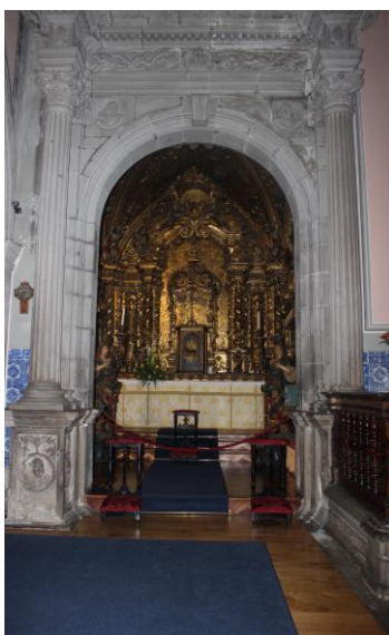
Fig. 35 – Vista da nave para a Capela do Santíssimo Sacramento
