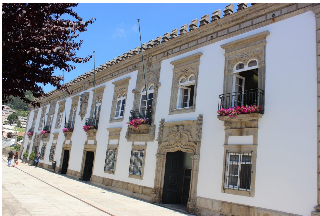
Fig. 131 – Vista geral da fachada do Palácio Visconde Carreira
