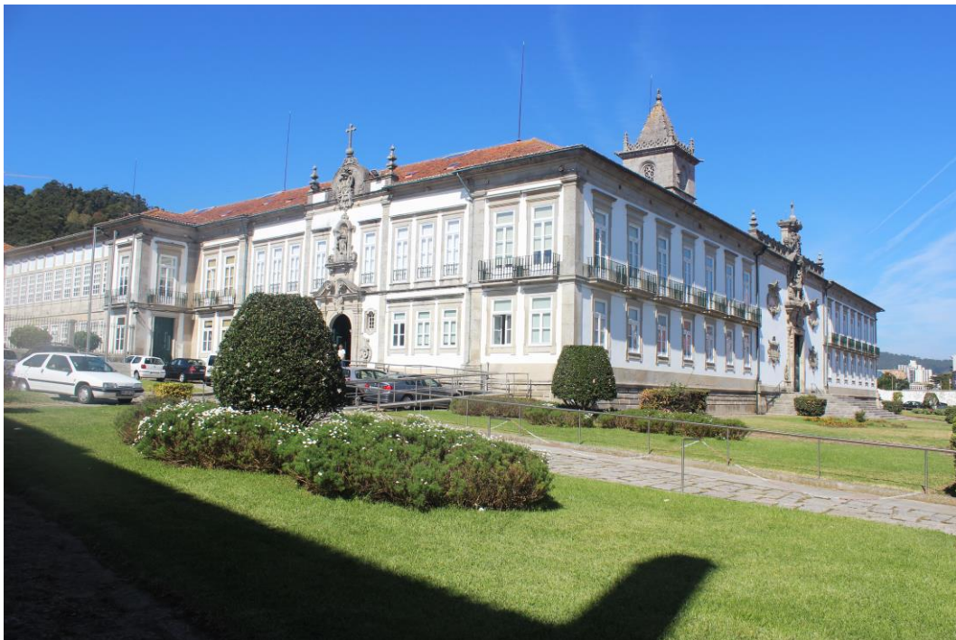
Fig. 213 – Convento de Santa Ana
