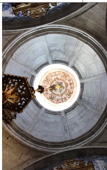
Fig. 58 – Cúpula e zimbório da igreja da Misericórdia
