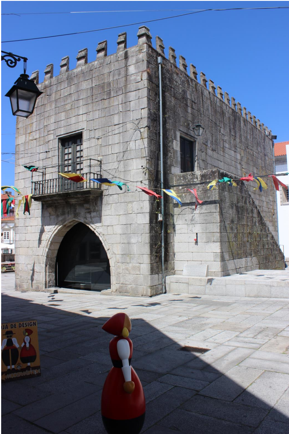
Fig. 299 – Fachada lateral e posterior
