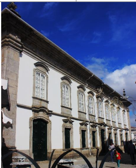
Fig. 179 – Fachada do palacete
