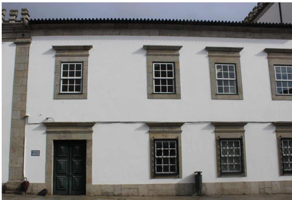
Fig. 276 – Pormenor da fachada da Casa dos Monfalim
