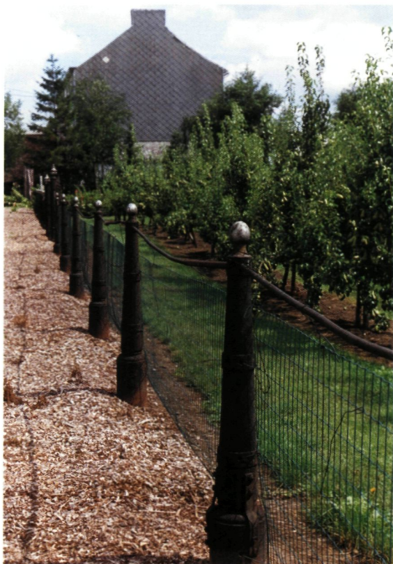
▲ De gietijzeren balie met zuiltjes verbonden door stangen, aan weerszijde van de gekasseide oprit naar het erf, uit de 19de eeuw, moet het vee in de fruitweiden houden
